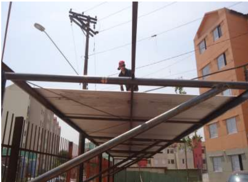
Jd. Arpoador – Cobertura do estacionamento.
