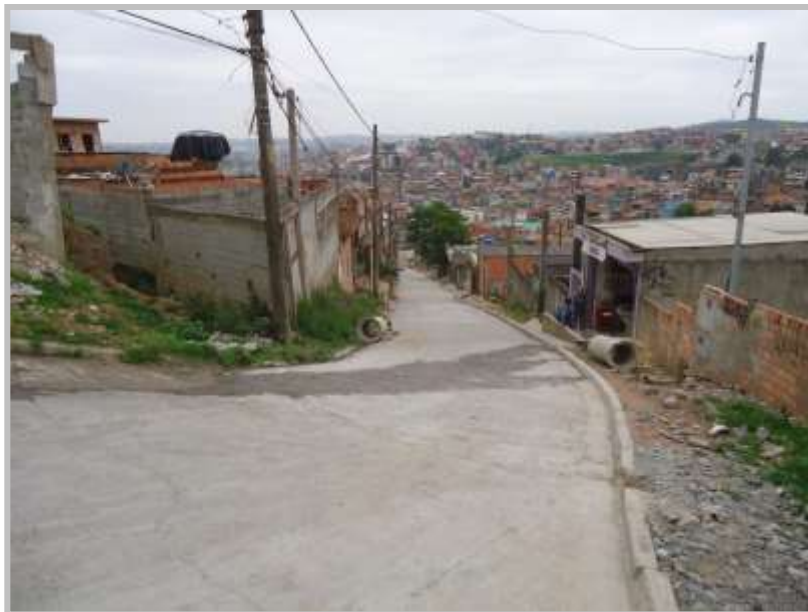
Execução da pavimentação – Rua Flamboyant
