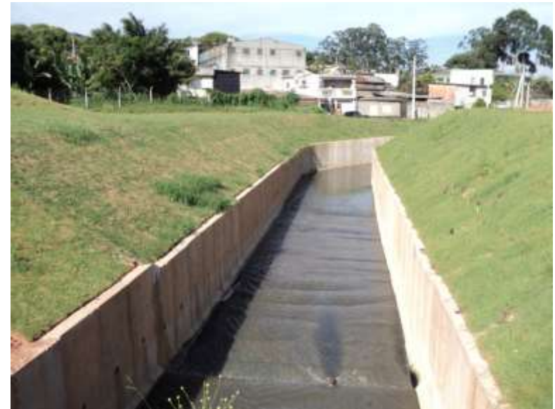
Cidade Júlia – Canalização Córrego Apucás
