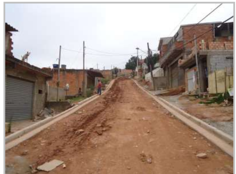
Execução de guias e sarjetas – AV. Cidade de Mauá
