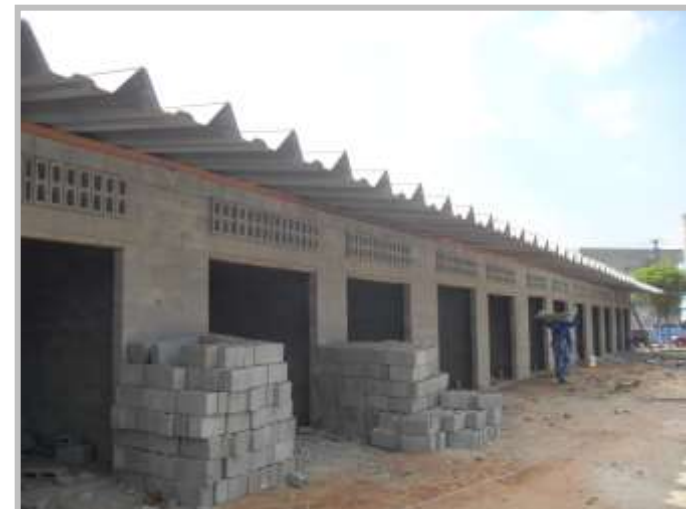
Execução da Cobertura – Centro Comercial – Fase 2
