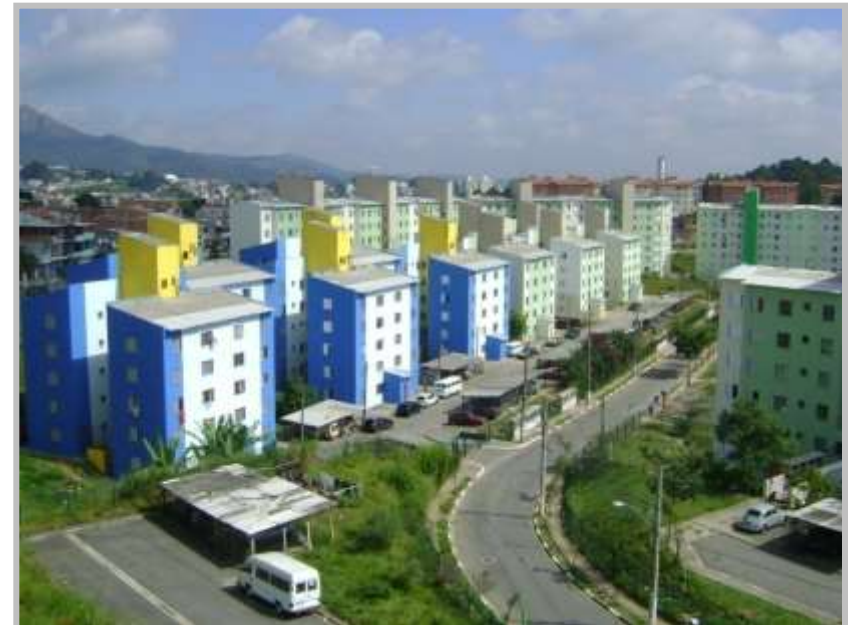
Vista – Condomínios C e D
