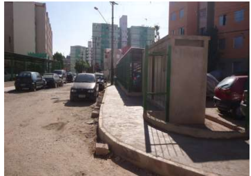
Jd. Arpoador – Execução de calçadas e cercamento em gradil.
