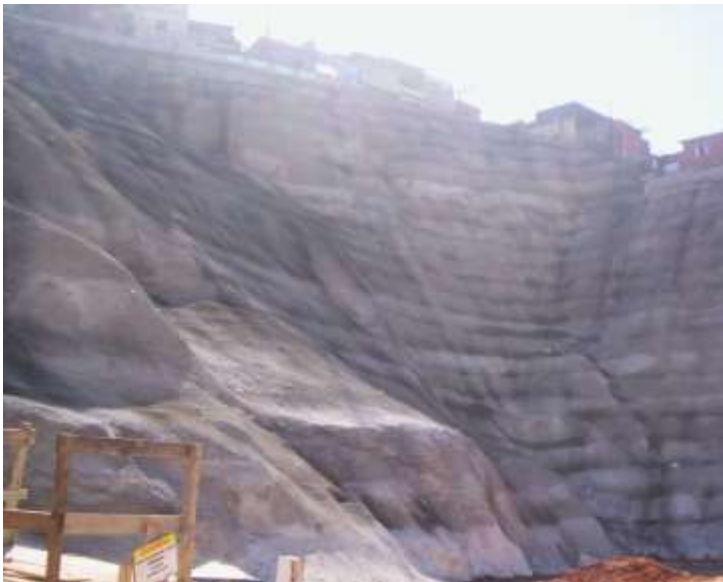
Cidade Júlia – Encosta Pedra Sobre Pedra - Serviços de Consolidação Geotécnica
