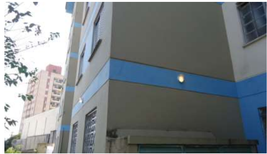
São Domingos – Instalação de equipamentos de combate a incêndio.
