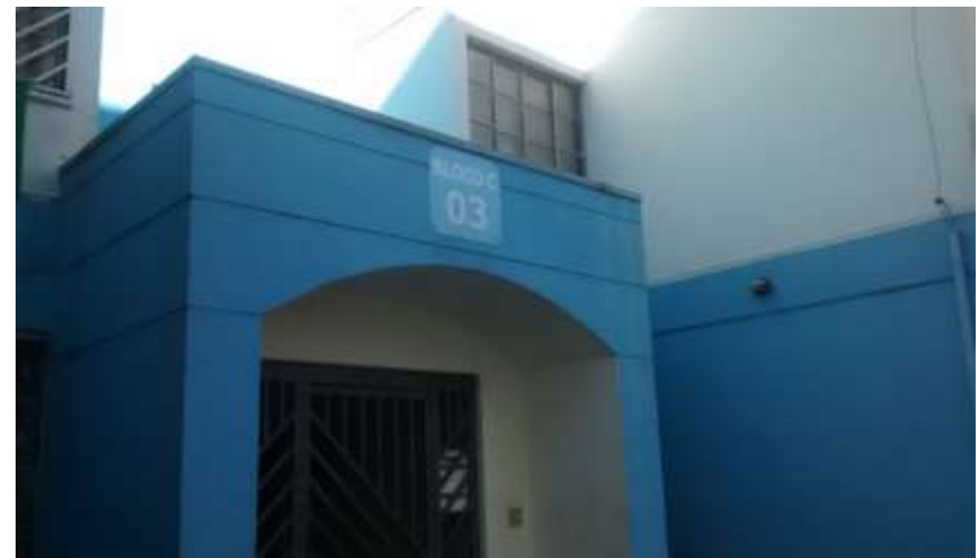
José Paulino – Instalação de corrimão, e complementação da pintura nas Quadras A e C.
