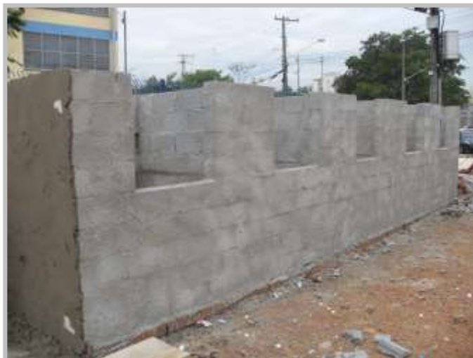
Alvenaria de elevação das lixeiras – Condomínio 4
