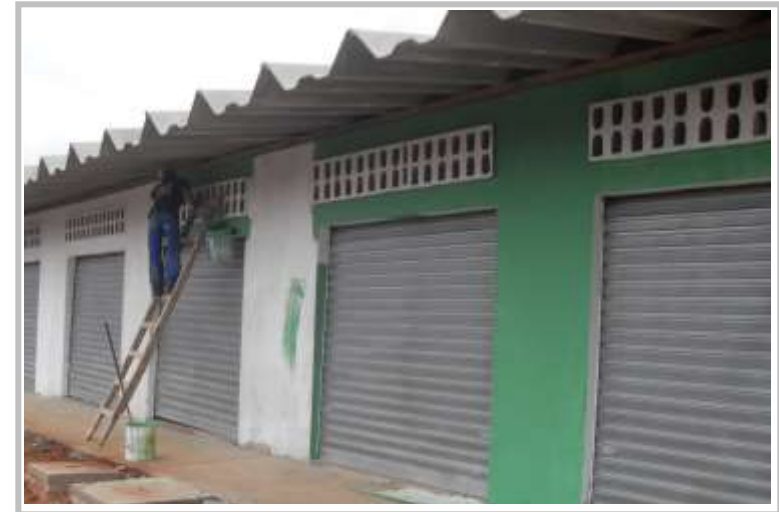
Acabamentos externos - Centro comercial – Fase 1
