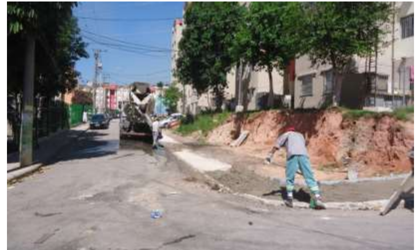
Jd. Arpoador – Execução de calçadas.
