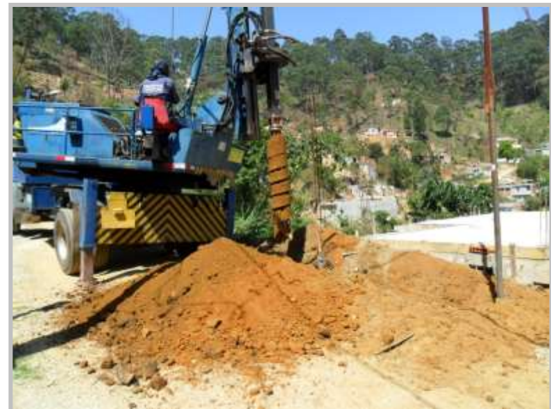
Execução da contenção da Rua Zabelê
