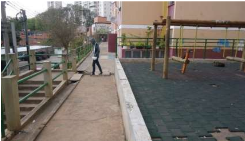
Jd. do Lago – Execução de áreas de lazer, instalação de kits gás, pintura externa dos prédios.
