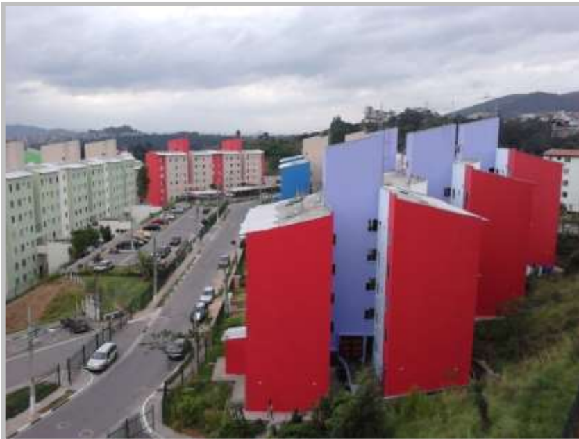
Vista – Condomínio G
