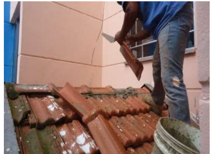
Parque Otero – Troca de telhas quebradas.
