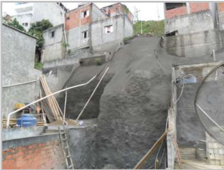
Execução do solo grampeado da Rua Faisão
