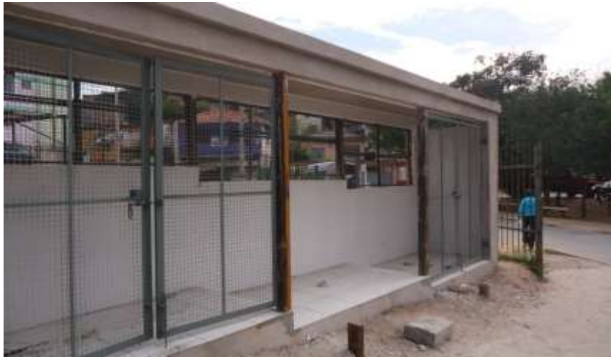
Jd. Arpoador – Construção de lixeiras.
