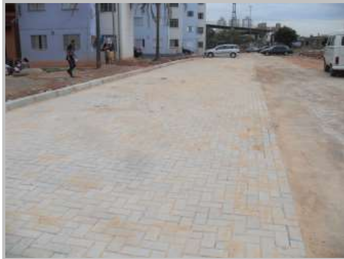
Pavimentação com piso intertravado – Condomínio 3
