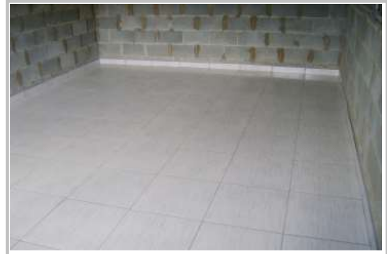
Colocação de pisos no Centro de Convivência
