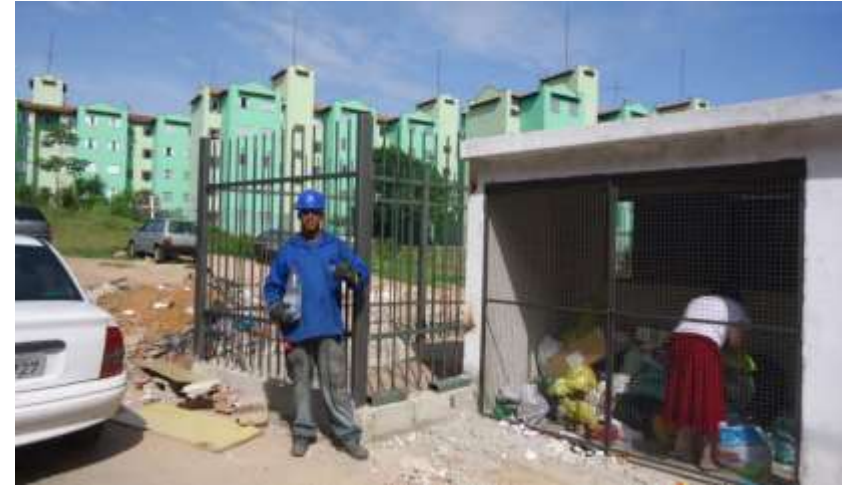
Parque Otero - Execução de lixeiras.
