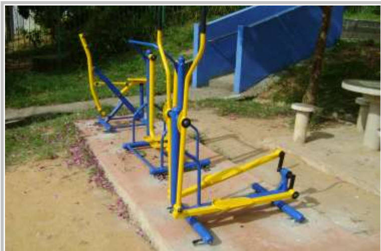
Instalação de equipamentos de ginástica
