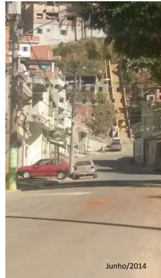
Itaberaba II – Vista loteamento no pós obras
