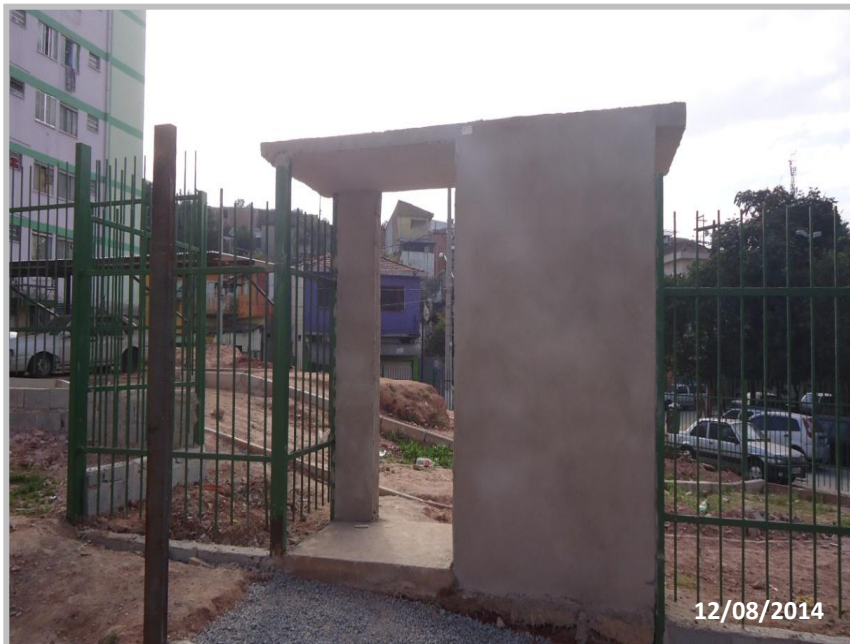
Jd. Arpoador – Construção de guarita.
