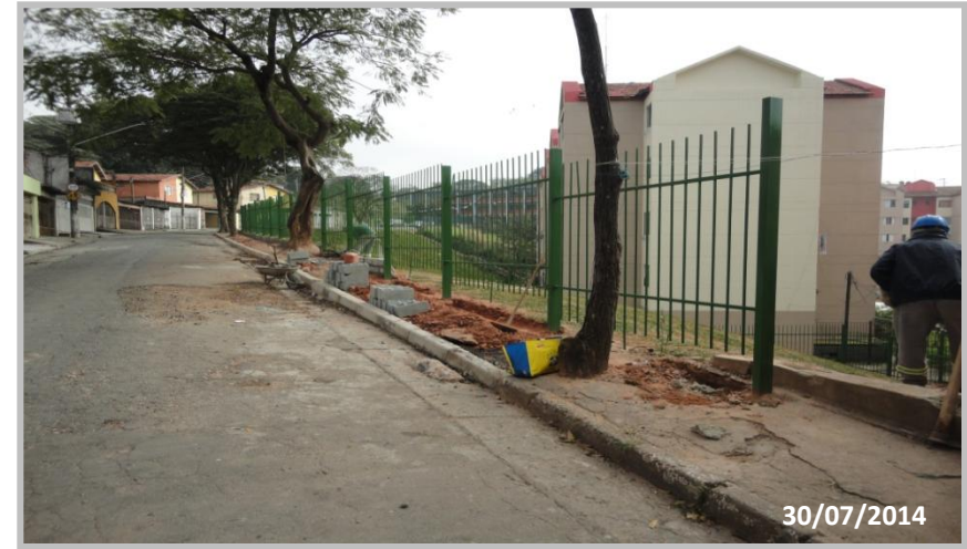
Jd. Arpoador – Instalação de gradil de fechamento.
