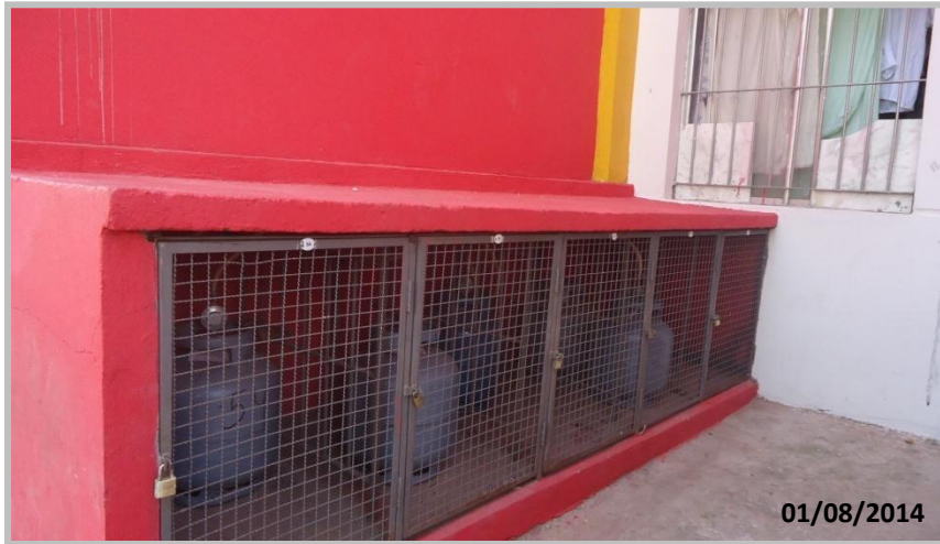
Campo Grande – Reforma dos abrigos de gás.
