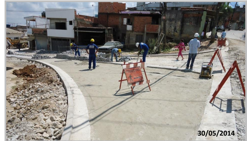
Pabreu / Prainha – Estrada da Ligação com a Rua Rio Branco - Serviços de Pavimentação
