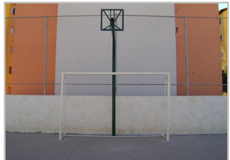
Reforma da Quadra Poliesportiva - Condomínio 2
