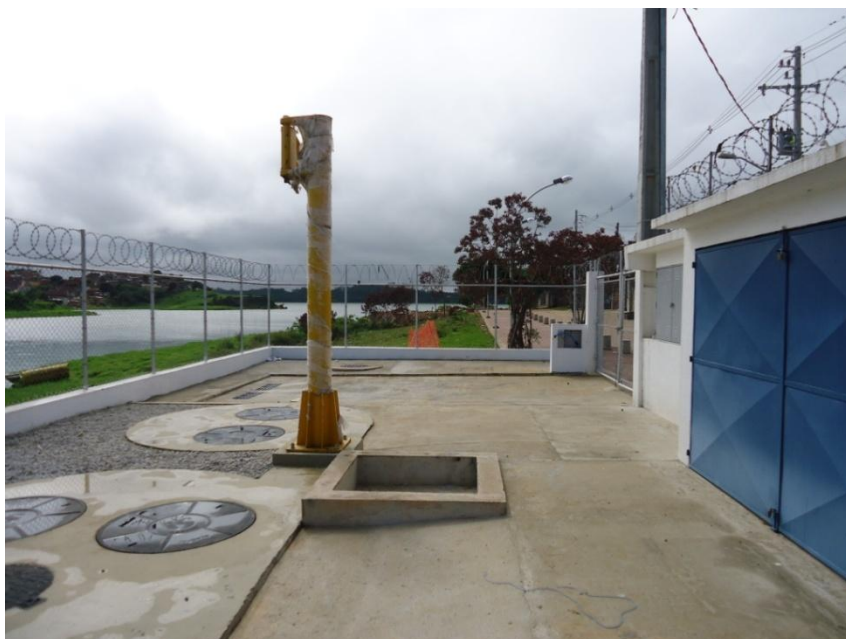
Pabreu / Prainha – Rua Beira Rio – Estação Elevatória de Esgoto
