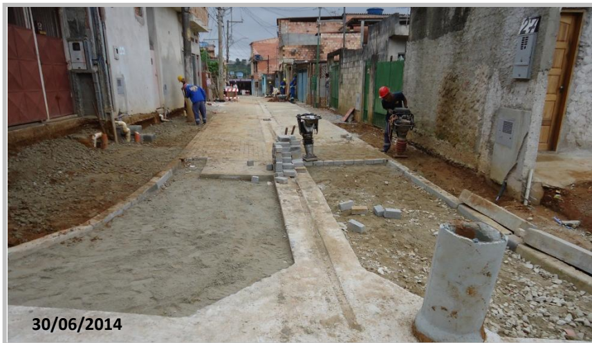
Pabreu / Prainha – Rua São João – Pavimento Intertravado –
