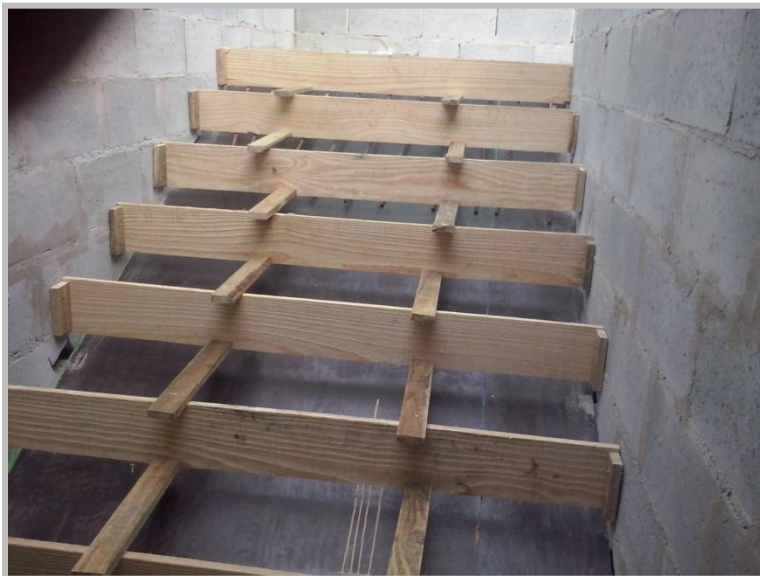
Execução de escada do centro de convivência
