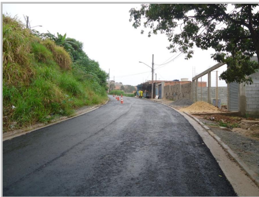
Pavimentação – Av. Adutora do Rio das Pedras
