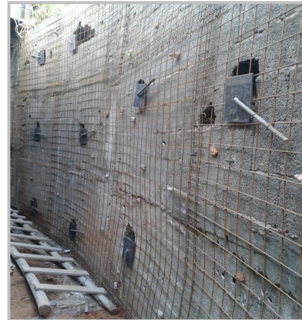
Execução de muro de contenção da Rua Iturama
