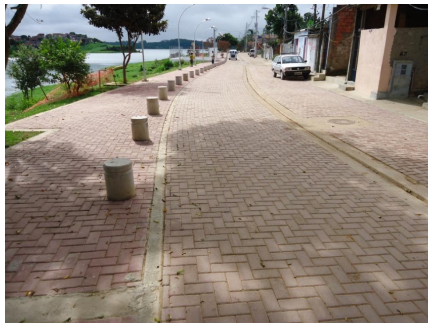
Pabreu / Prainha – Rua Beira Rio – Pavimentação
