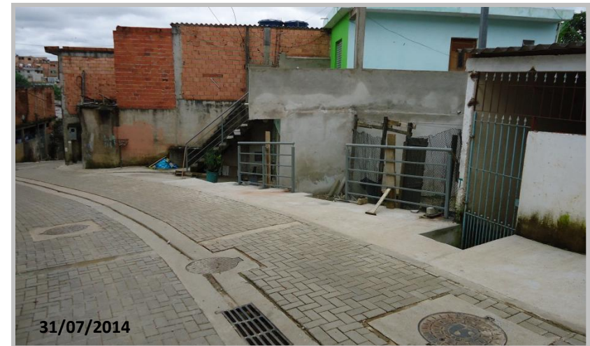
Pabreu / Prainha – Rua Vitória - Pavimento Intertravado
