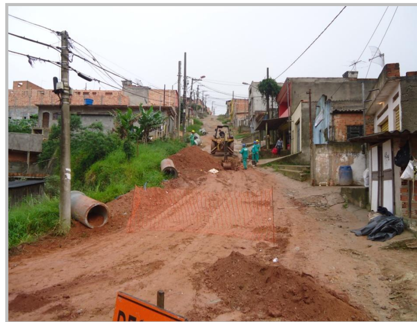
Execução de rede de drenagem – AV. Cidade de Mauá
