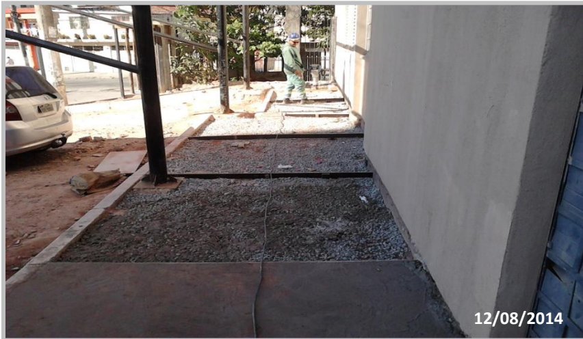
Jd. Arpoador – Construção de calçadas.
