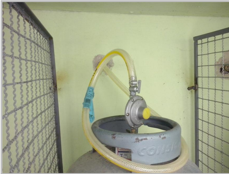
Instalação de Kit Gás
