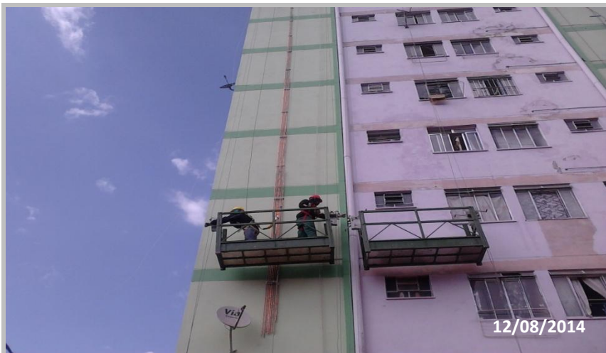
Jd. Arpoador – Instalação da tubulação de gás.
