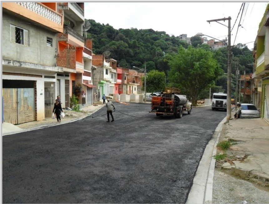
Execução de Pavimento Asfáltico da Rua Pelicano
