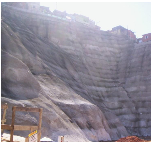
Cidade Júlia – Encosta Pedra Sobre Pedra - Serviços de Consolidação Geotécnica
