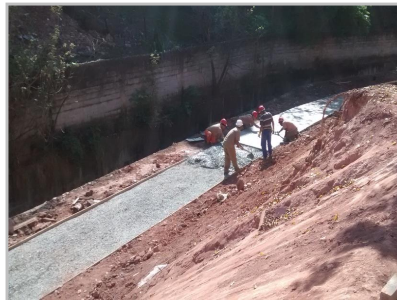
Gerenciamento de Obras: Parque Otero
