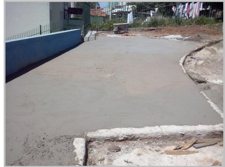
Execução de Passeio de Concreto
