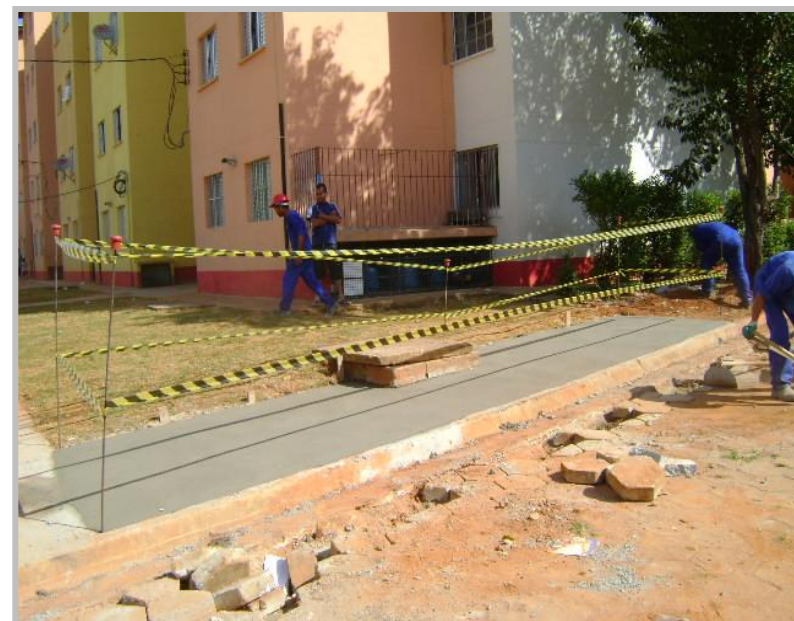
Gerenciamento de Obras : 3R's – Lote D – Bela Vista
