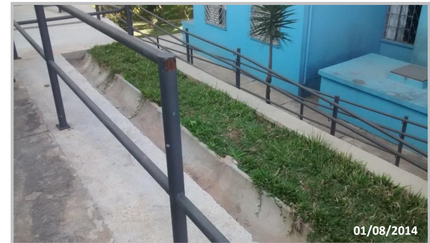
José Paulino – Instalação de corrimão.
