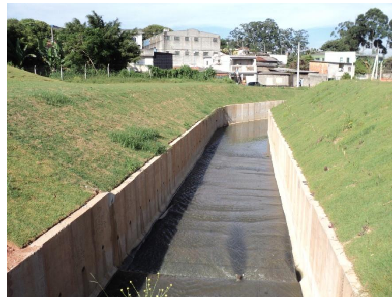
Cidade Júlia – Canalização Córrego Apucás
