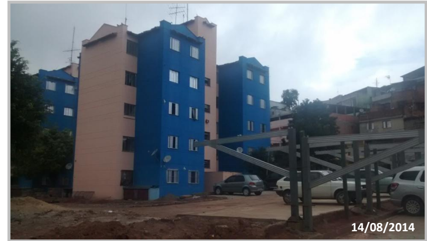
Parque Otero – Estrutura da cobertura do estacionamento.
