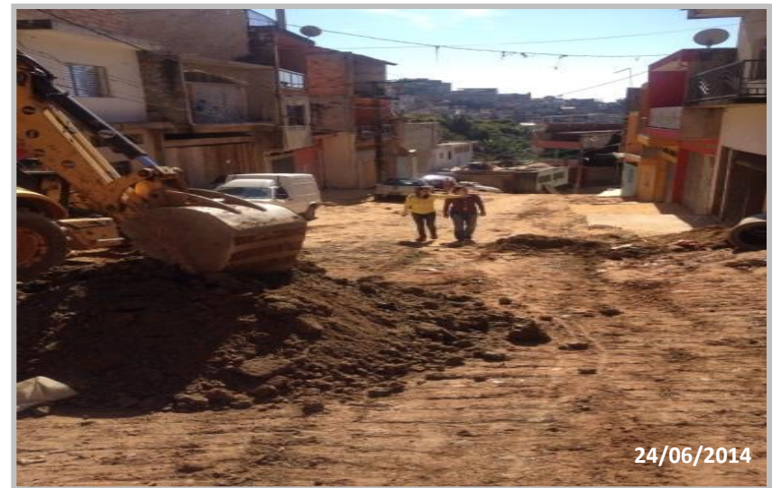
Itaberaba II – Acompanhamento de famílias em fase de Obras
