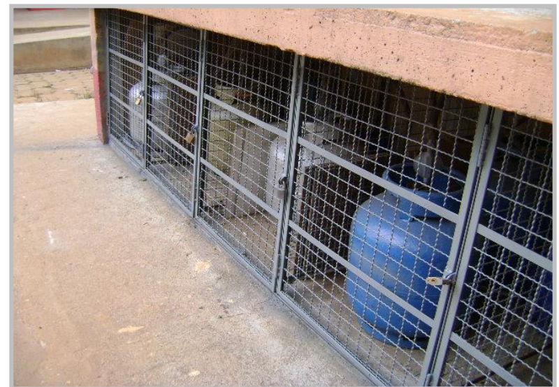
Instalação das Portinholas do Abrigo de Gás- Condomínio 2
