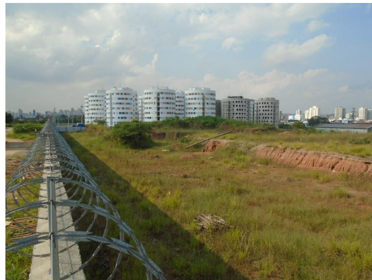
CONDOMÍNIO 3A – OBRAS A SEREM INICIADAS
