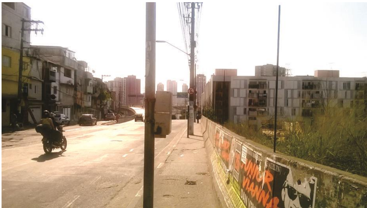
POSTES DA ELETROPAULO A SEREM REMOVIDOS OU REMANEJADOS PARA LIBERAÇÃO DE FRENTE DE OBRA
