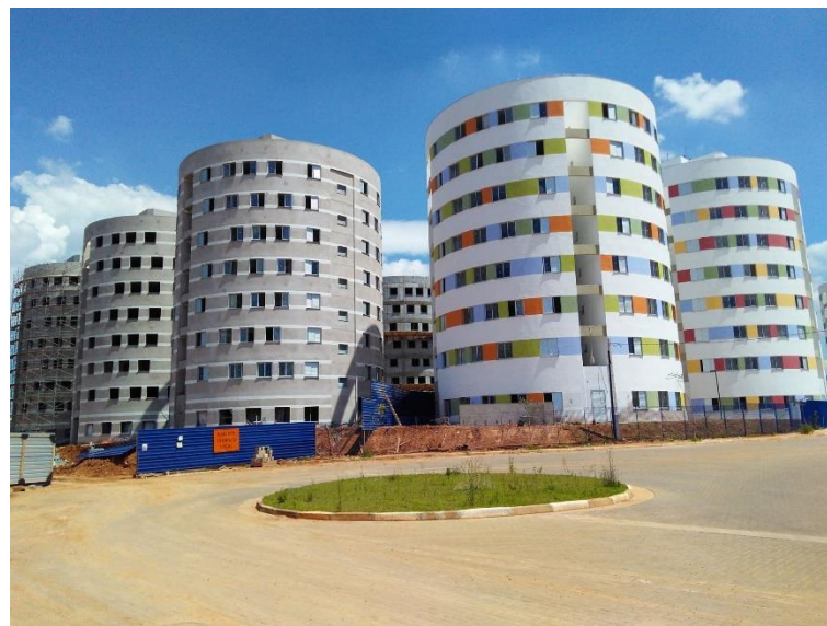
CONDOMÍNIO 1 – BLOCOS 3, 4, 5 E 6 (À ESQUERDA DA FOTO)
