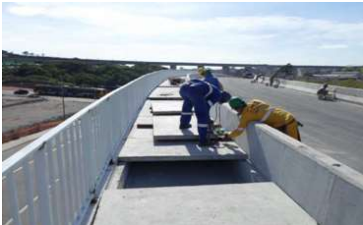
Colocação das placas pré-moldadas na passagem de pedestre
