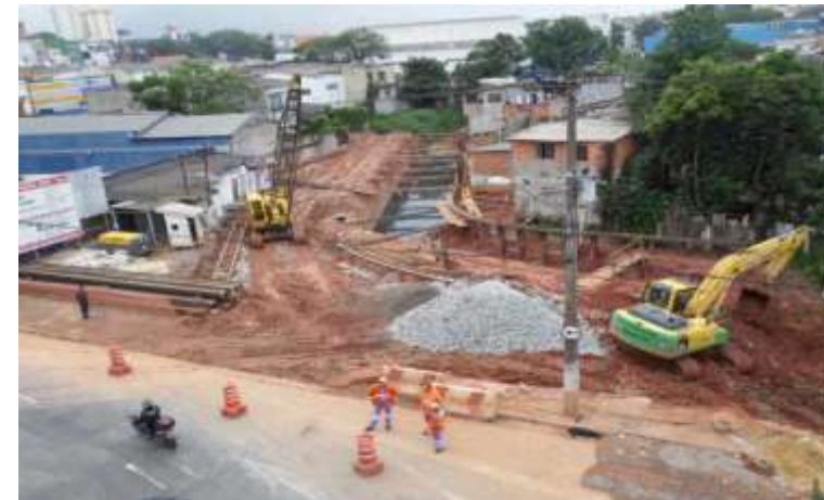
Corte, Aterro e execução de contenção para execução do canal.
