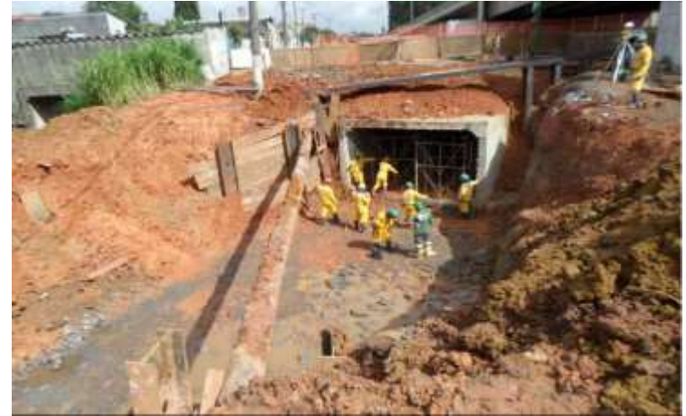
Execução da regularização do fundo da vala para execução da laje de fundo do canal
