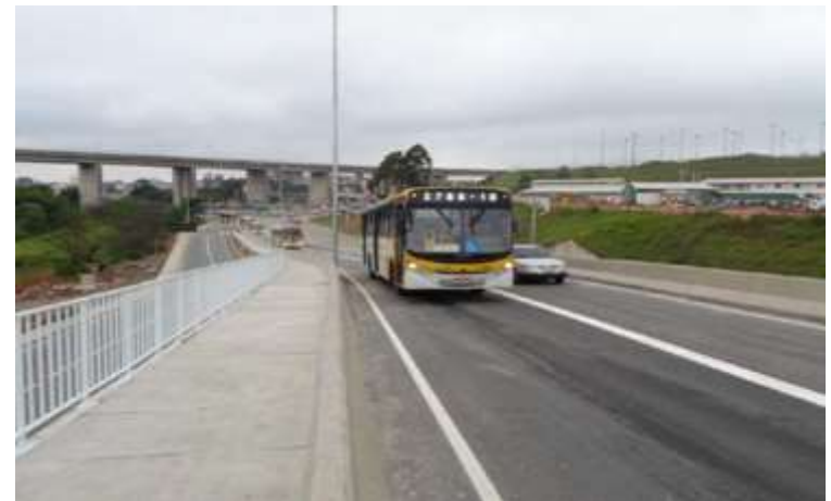
Viaduto em funcionamento
