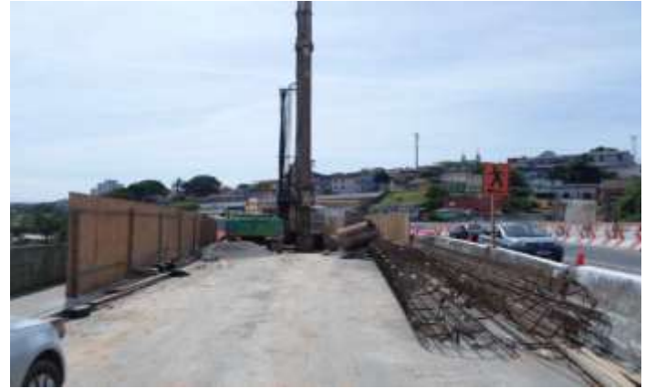
Execução dos estações para a segunda etapa da Passagem inferior sentido centro
