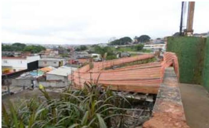
Implantação de passagem para execução das estações da Passagem inferior sentido centro.
