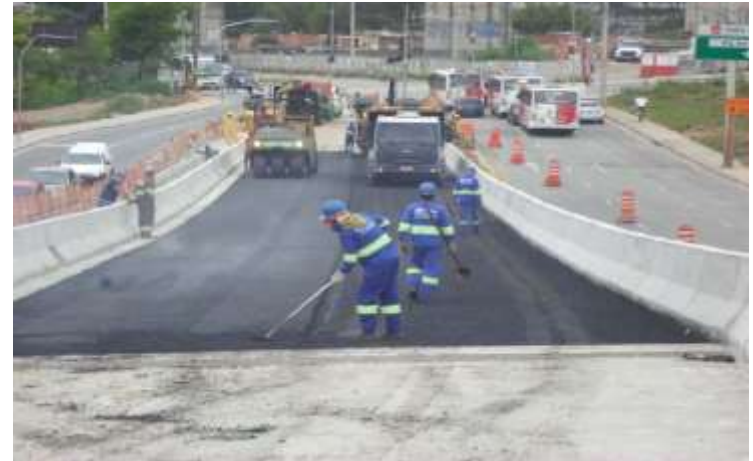
Execução da pavimentação do viaduto
