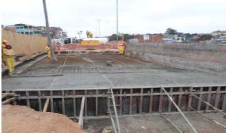
Execução da concretagem da laje superior da Passagem inferior – sentido bairro
