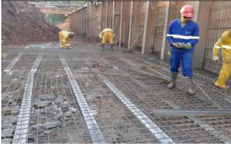
Execução de armação de laje de fundo do canal
