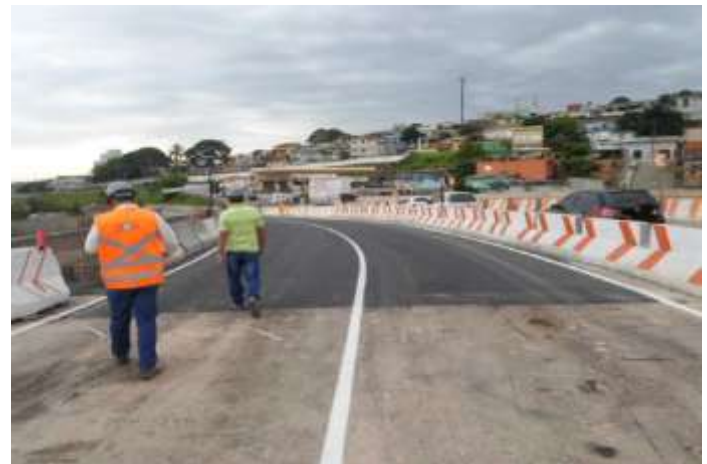
Pavimentação executada sobre laje inferior sentido bairro
