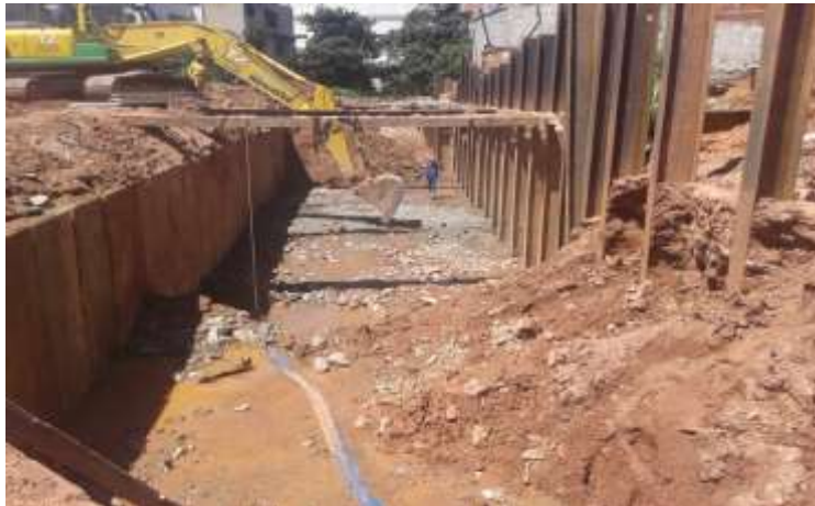
Execução das atividades no sentido contrário à contenção do canal
