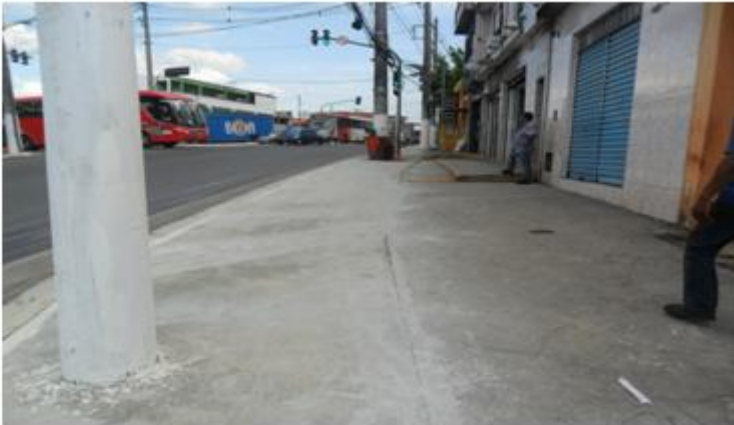
Implantação de alargamento viário e construção do passeio entre a Rua Inácio Monteiro até a Rua Luis Mateus.
