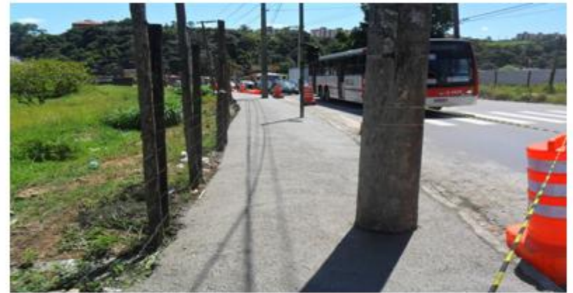
Execução de passeio para acessibilidade às baias e pontos de parada.
