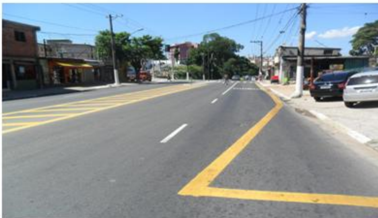
Pavimentação e sinalização de 16 pontos de parada.
