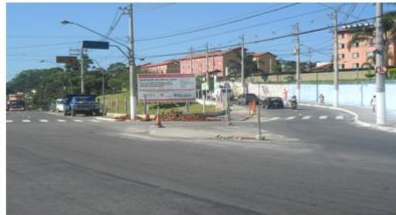
Implantação do binário formado pela Estrada do Iguatemi e Rua Itiruna (sentido bairro-centro).
