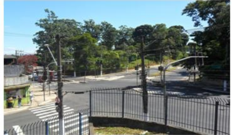
Pavimentação e sinalização do entroncamento da Estr. do Iguatemi com a Rua Marcio Beck
