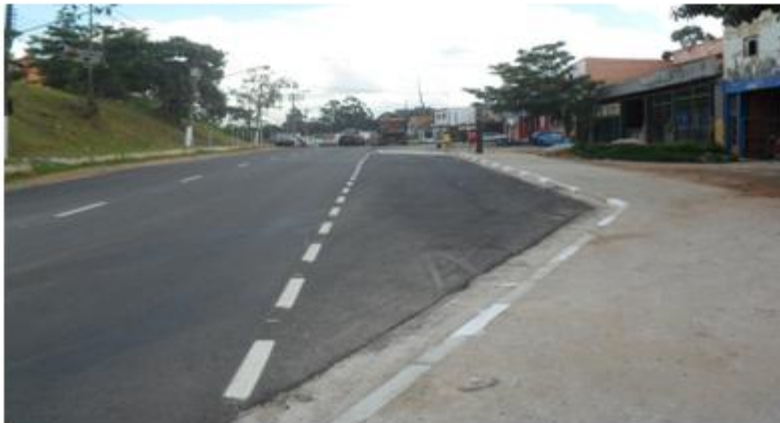
Implantação de 14 baias ao longo da via.
