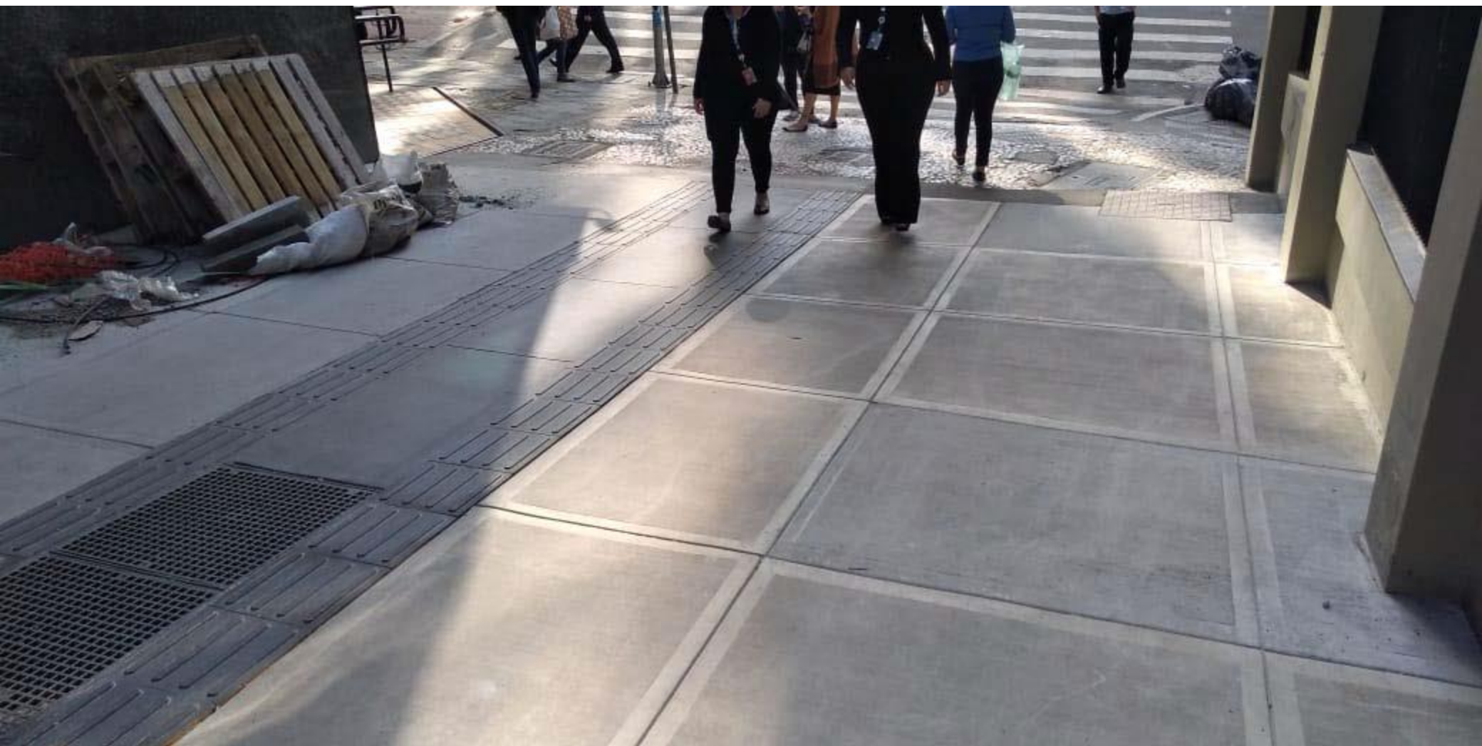
Imagem do Projeto Piloto em obras
