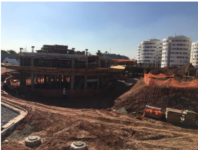
CONDOMÍNIO 3A – OBRAS A SEREM INICIADAS
