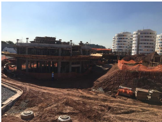
CONDOMÍNIO 3A – OBRAS EM ANDAMENTO
