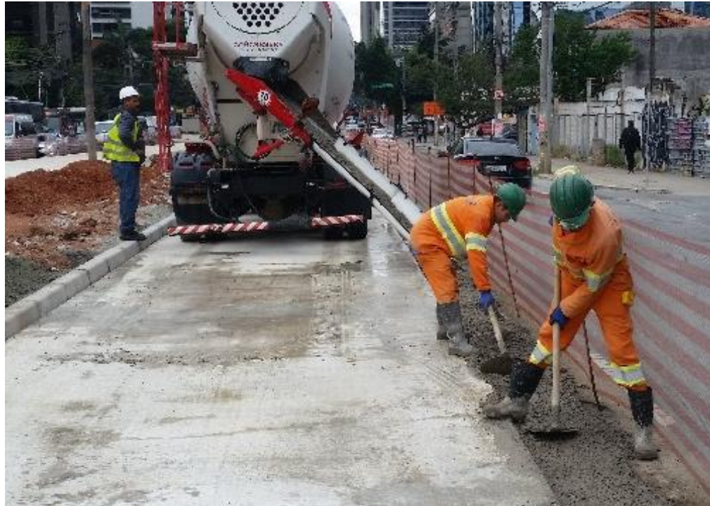
Corredor Berrini - Obra
