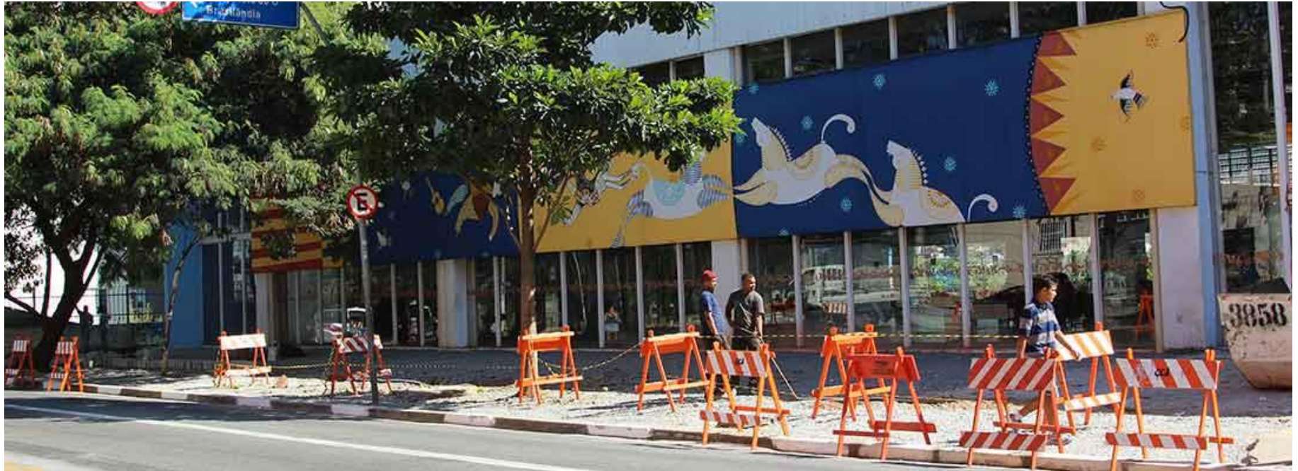
Centro Cultural da Juventude – Restauro da fachada
