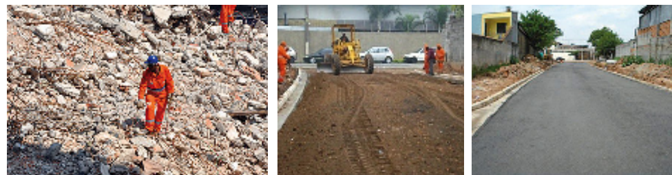
RCC de demolições utilizado na execução de pavimentos
