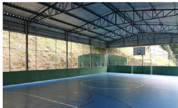
2. Cobertura de quadra. M'Boi Mirim
