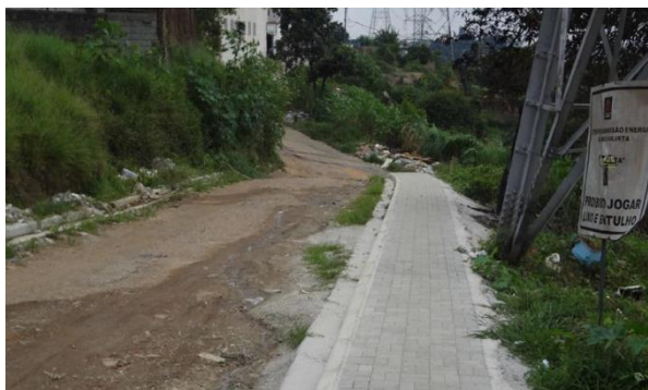
1. Construção de passeio e viela. Capela do Socorro
