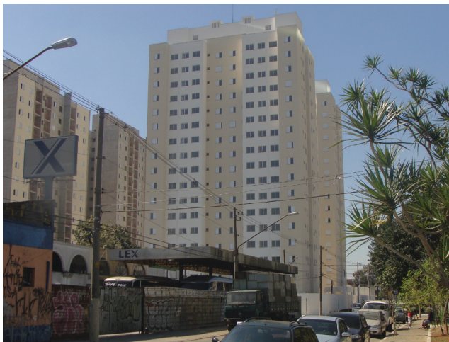
Foto 3: Ocupação residencial vertical nova na Rua Odorico Mendes.
