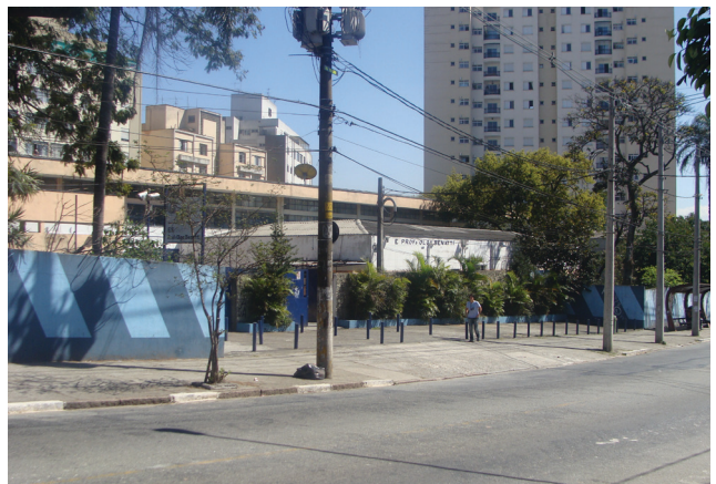
Foto 14: Ocupação residencial vertical no entorno de uma escola do setor Vila Prudente.
