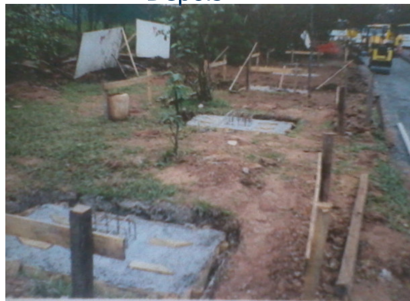
Fundação dos novos abrigos
