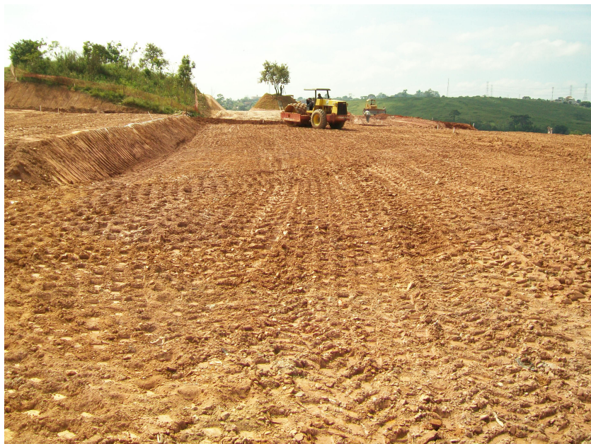
Terraplenagem Chácara do Conde
