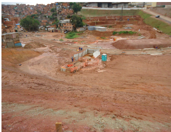
Estação Elevatória de Esgoto: Obras em andamento
