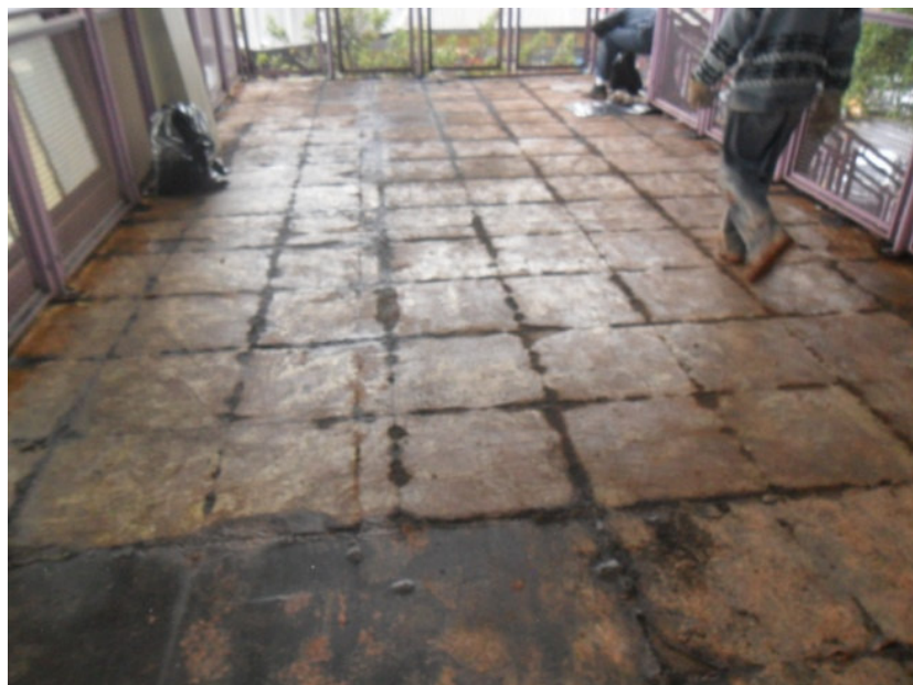
Piso da passarela a ser removido
