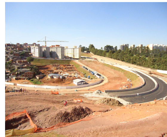
Av. Perimetral: Obras em andamento
