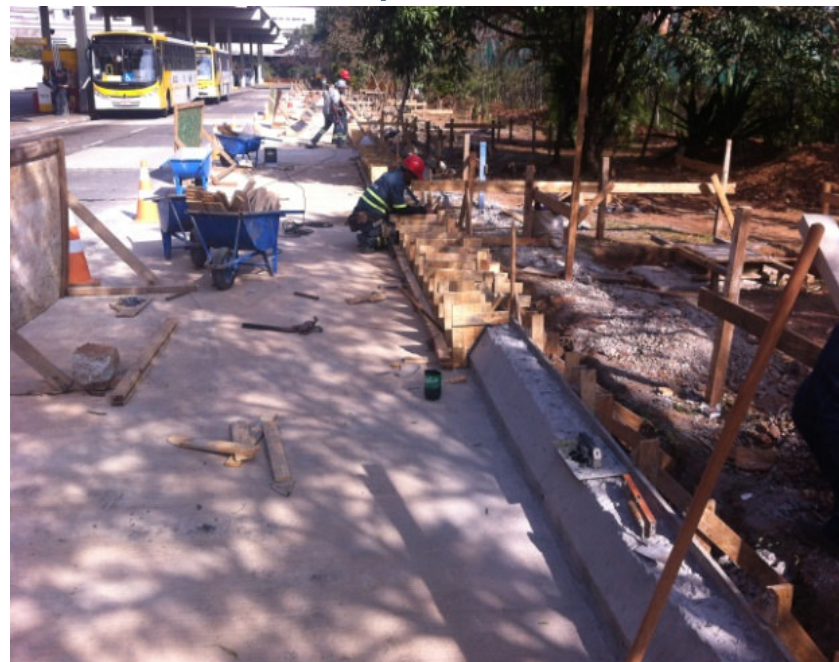
Execução das superguias
