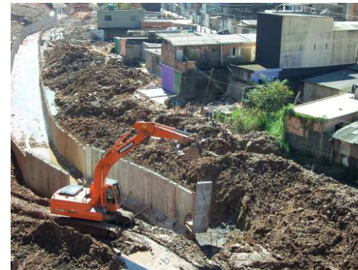
Canalização córrego São João
