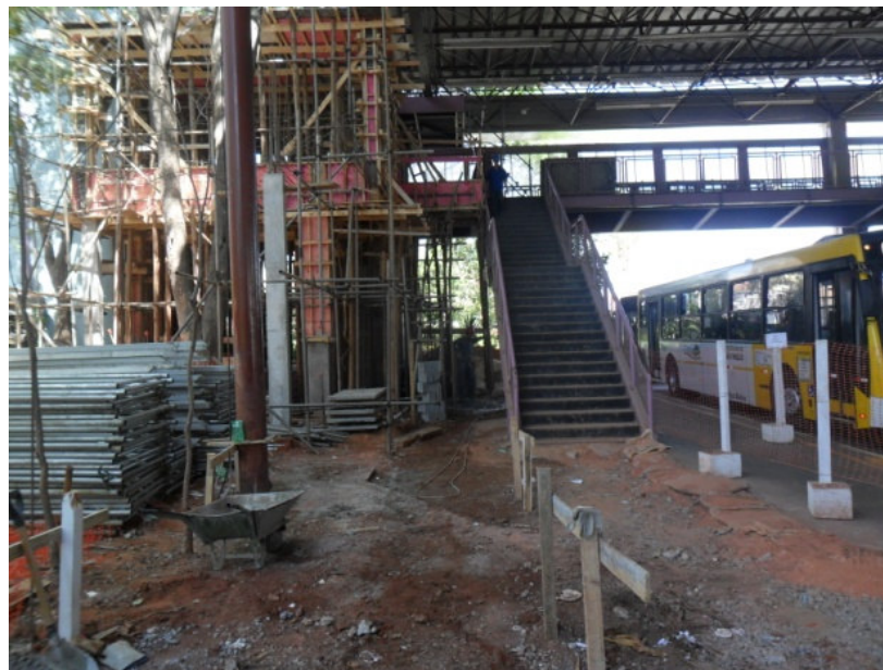
Prédio administrativo em construção
