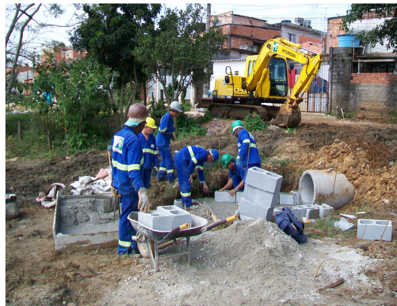
Execução obras de drenagem Rua da Paz
