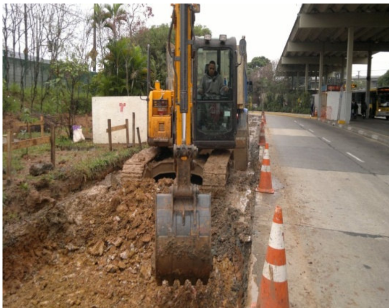
Abertura de caixa para pavimento
