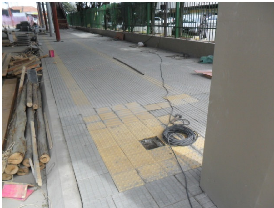
Plataforma em fase de acabamento
