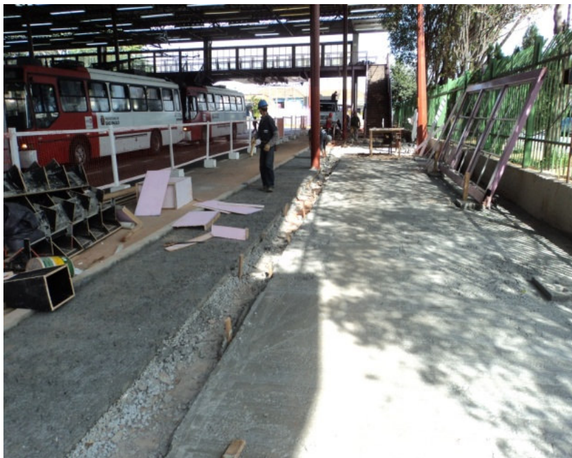
Nova plataforma em execução
