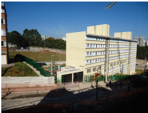
Condomínio G: Serviços em fase de acabamento
