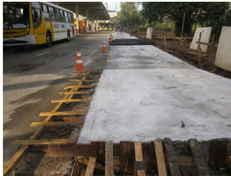
Pavimento rígido novo
