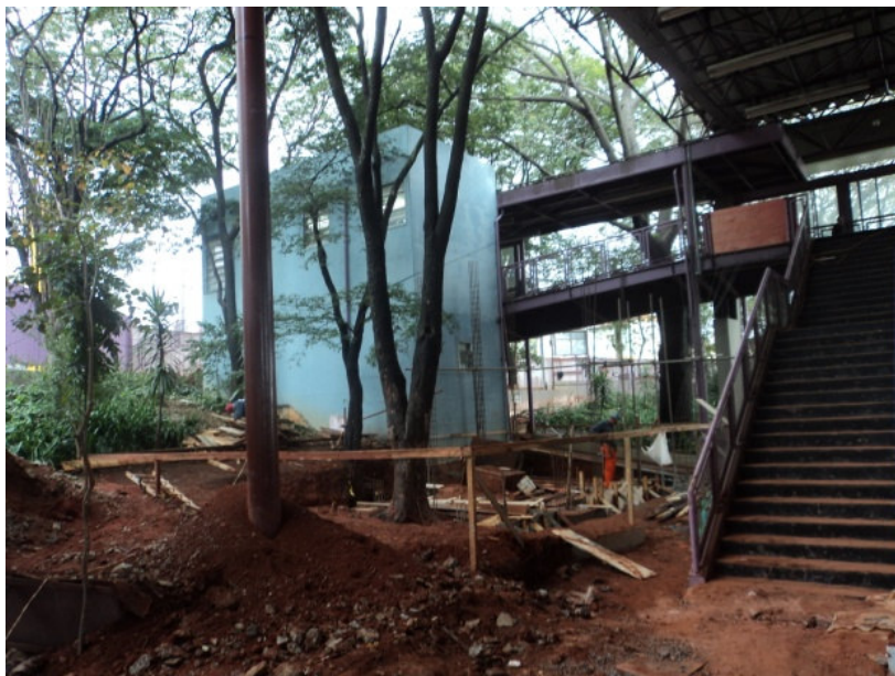
Local de implantação do novo prédio administrativo
