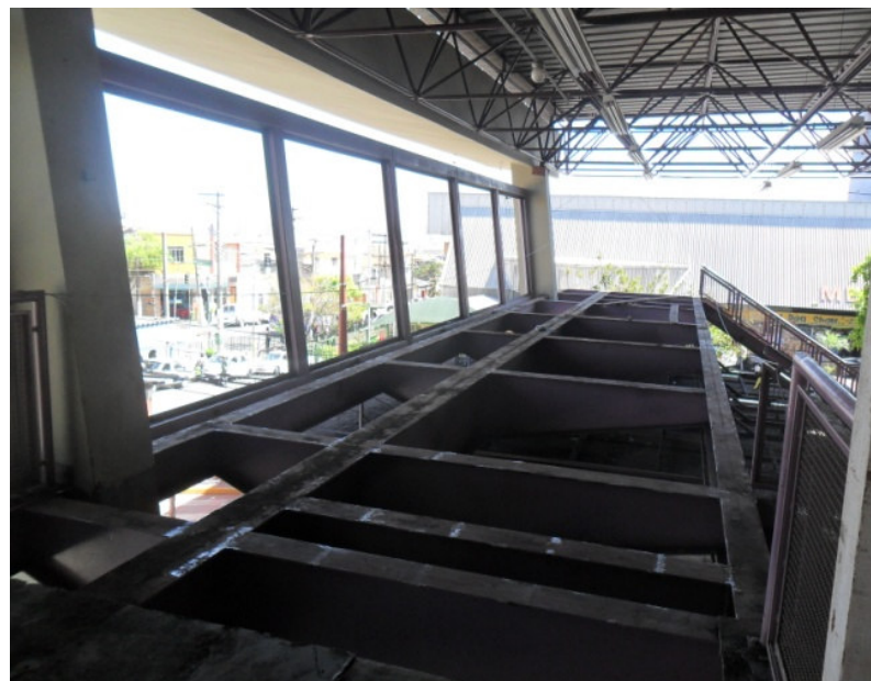
Estrutura da passarela em fase de acabamento para receber novo piso
