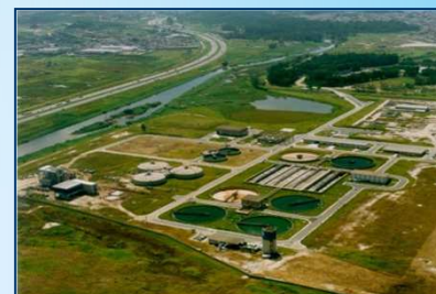
ETE São Miguel – 1.500 I/s
