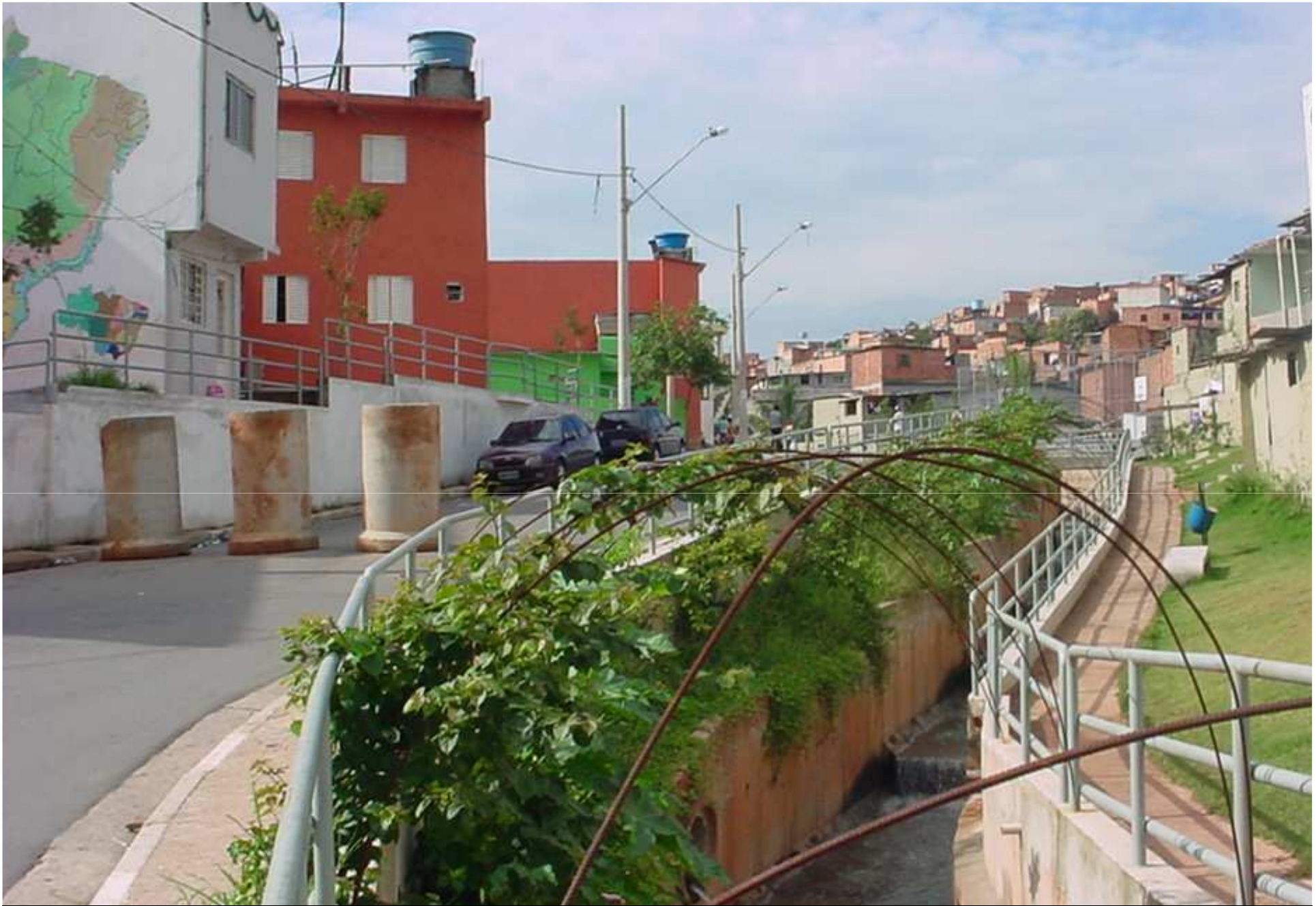
CÓRREGO BREJO DEPOIS
