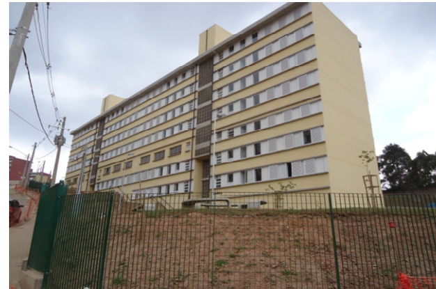
CONDOMÍNIO G: Serviços concluídos em dezembro/2012
