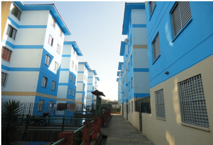
JARDIM IMPERADOR: Serviços concluídos em dezembro/2012
