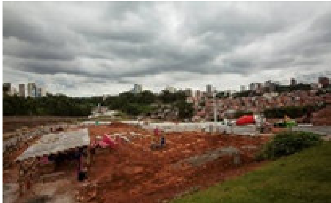
CONDOMÍNIO G: Antes
