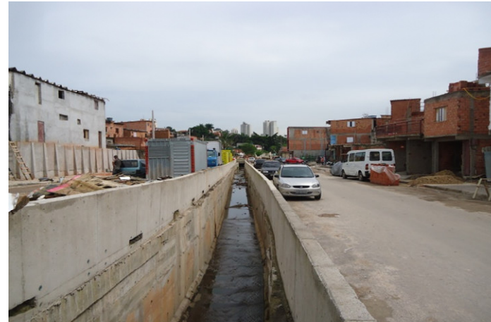
CÓRREGO DO BREJO: Canalização concluída
