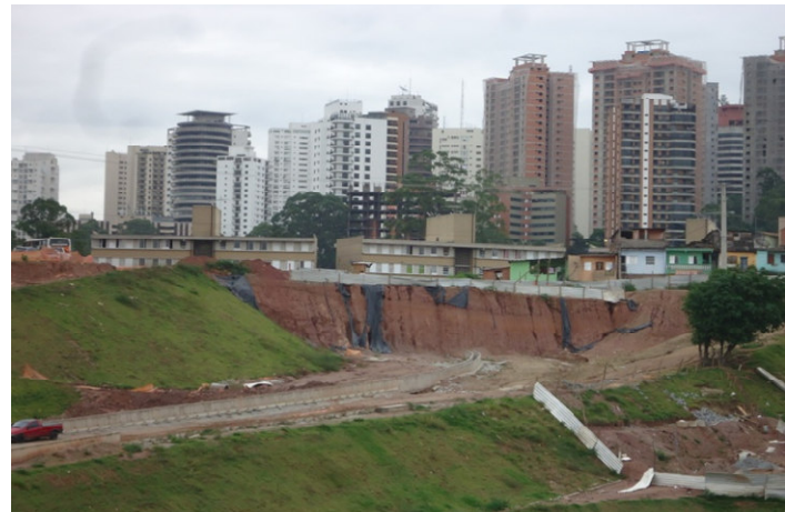
AV. PERIMETRAL: Obras em andamento
