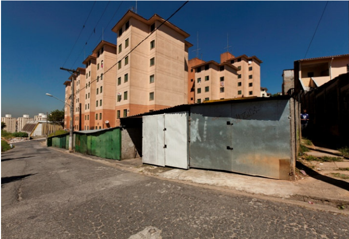
JARDIM IMPERADOR: Antes das Obras
