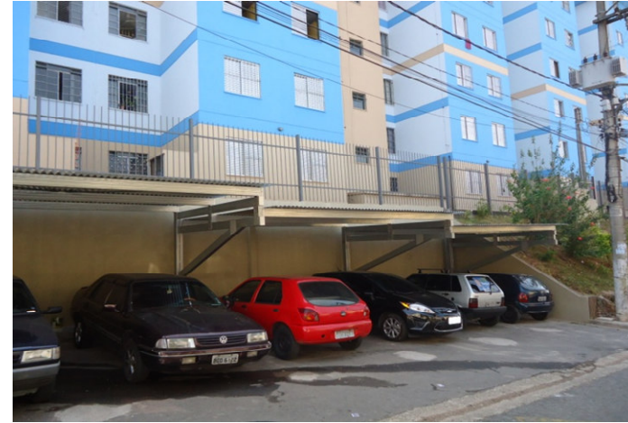
JARDIM IMPERADOR: Concluído cobertura dos estacionamentos
