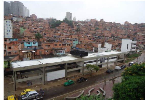
GROTINHO 2: Serviços concluídos em dezembro/2012
