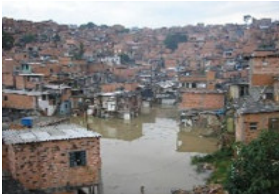
GROTINHO 2: Antes das Obras
