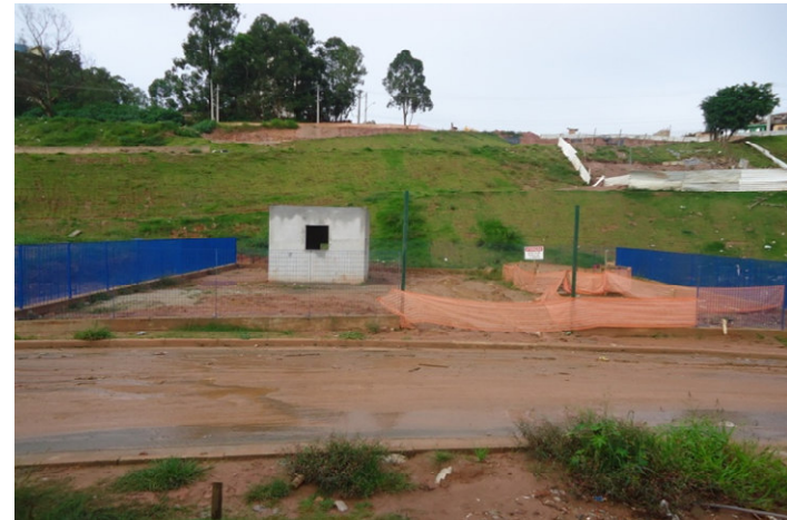
ESTAÇÃO ELEVATÓRIA DE ESGOTO: Obras em andamento
