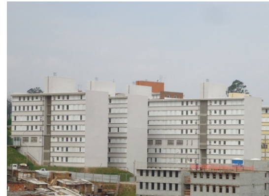
CONDOMÍNIO E: Serviços concluídos em dezembro/2012
