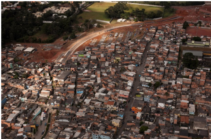
CÓRREGO DO BREJO: Antes
