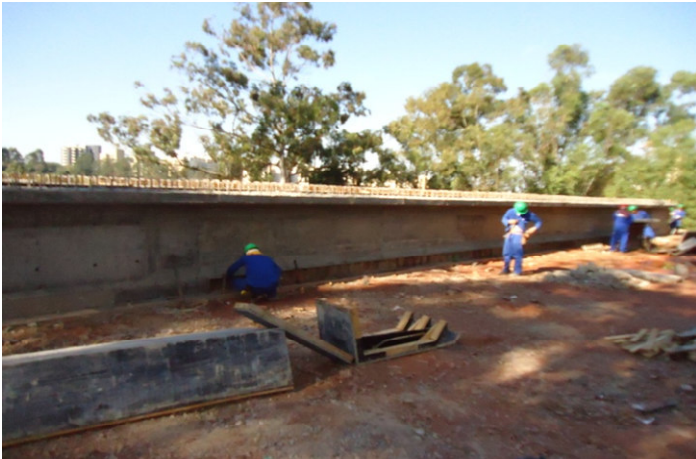
VIADUTO DA PERIMETRAL: Antes
