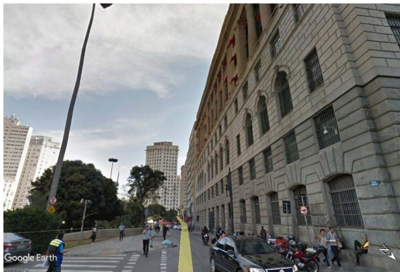
Foto 3 – Vista da Rua Formosa. O imóvel encontra-se a direita.
