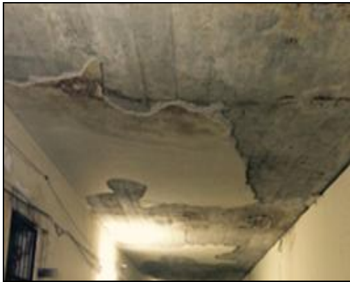
Foto 9: Teto desabando sobre a área
