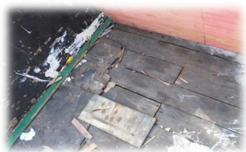
Foto 19: Condições inadequadas da carroceria
