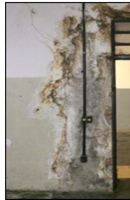
Foto 10: Problemas com infiltrações
