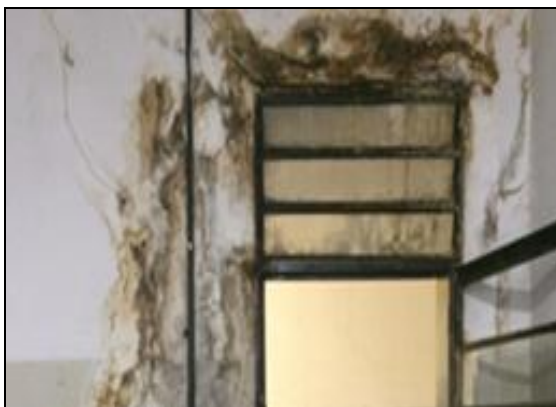
Foto 12: Problemas com infiltração
