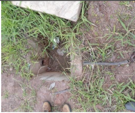
Foto 10 - Local com caixas de passagem antigas e sem grama
