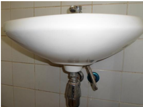
Foto 12 - Lavatório de Louça Branca, sem coluna – Guarita 1 (Rodoanel)
