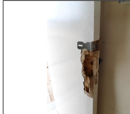
Foto 11 - Porta Danificada – Guarita 2
