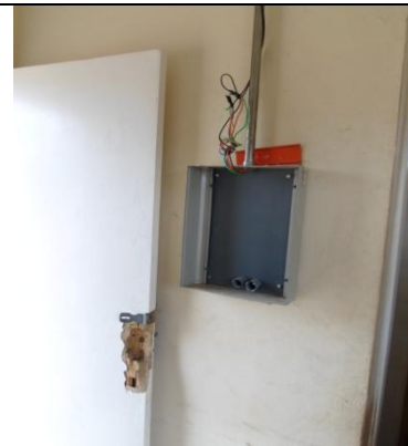
Foto 13 - Quadro de distribuição não montado – Guarita 2
