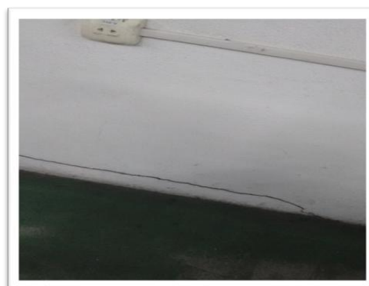
Foto 52: Rachaduras na parede
