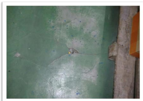
Foto 49: Piso com rachadura
