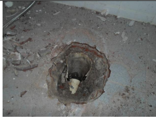
Foto 11 - Sanitário sem a respectiva bacia
