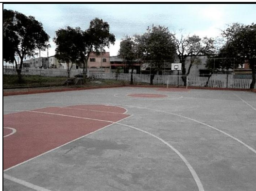
Serviço executado na Quadra do Sabipa com tinta acrílica e pintura parcial do piso (foto encaminhada pela Unidade)
