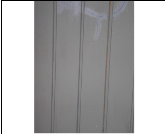
Foto 4 - Porta mexicana instalada com pintura na parte lateral direita sobre tinta antiga.
