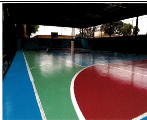
Serviço executado em quadra de outra Unidade, pintada com tinta à base de borracha clorada (foto tirada de outro processo executado pela EEC)
