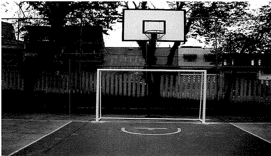
Foto – Trave nova substituída
