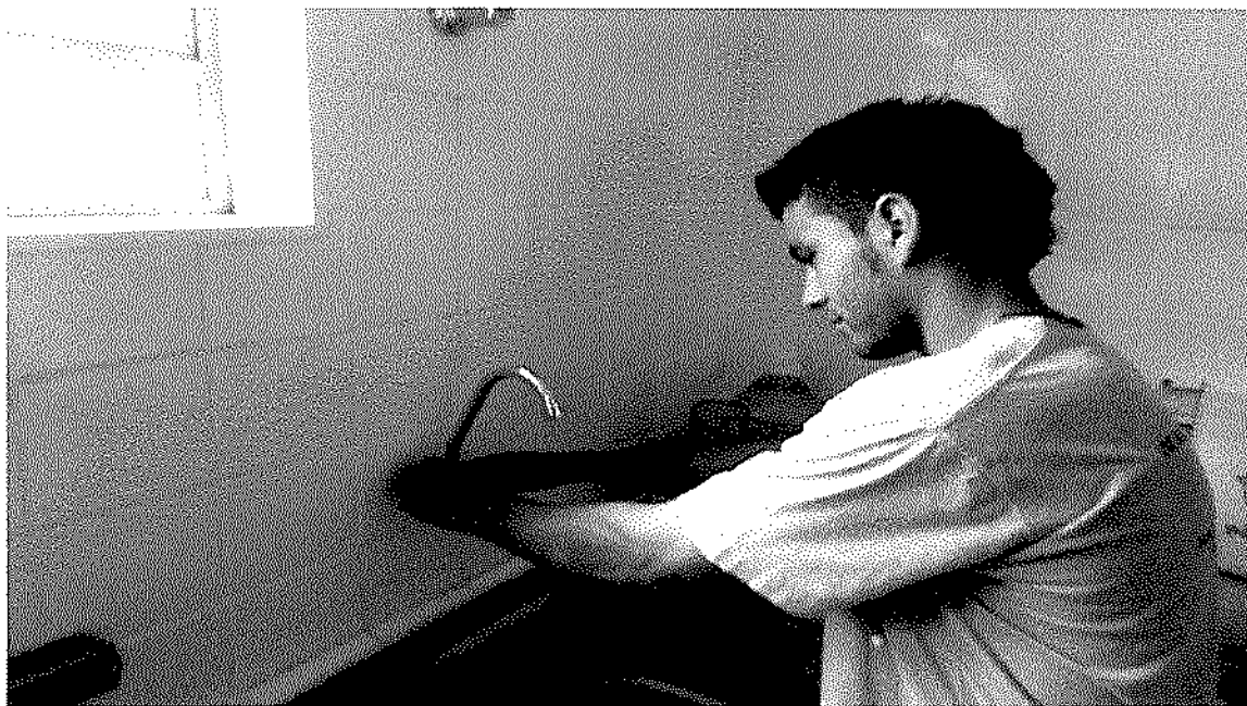
Foto – Instalação da nova torneira
