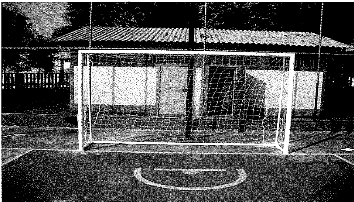
Foto – Trave nova substituída e rede instalada
