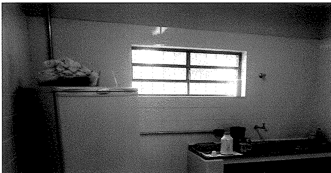
Foto 06 – Após término dos serviços
