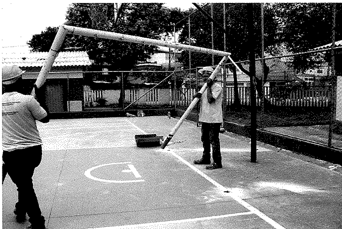
Foto – Remoção da trave danificada
