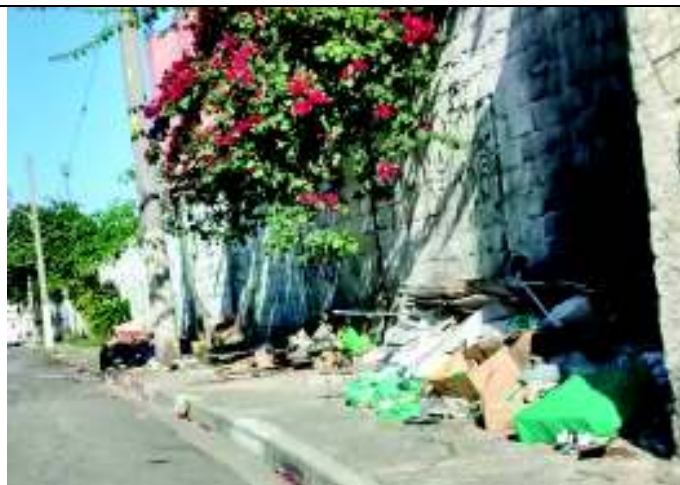
Varrição precária e acúmulo de entulho e lixo em rua paralela ao viaduto da Lapa.
