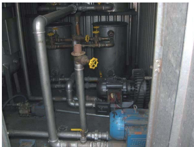
Figura 41 – Sistema de Extração de Gases instalado na área das escolas EMEI Vicente Paulo da Silva e EMEF Clóvis Graciano
