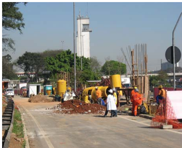
Figura 48 – Construção da Obra de Arte OAE-203, alça de acesso junto a Ponte das Bandeiras, vistoria realizada em 01/09/2009.
