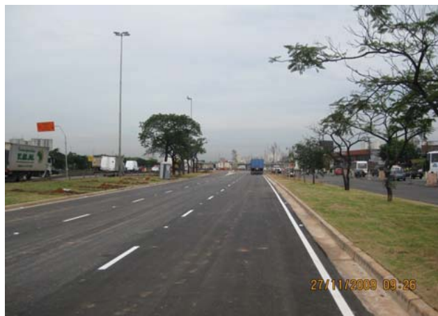
Figura 52 – Trecho finalizado nas proximidades da Ponte do Piqueri, vistoria realizada em 27/11/2009.
