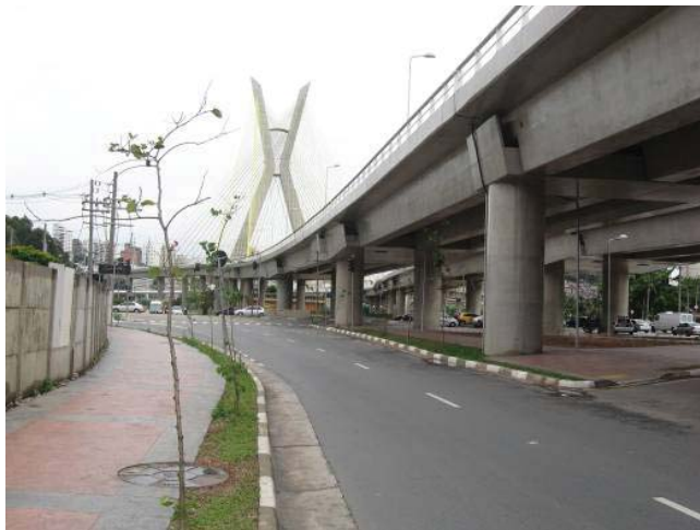
Figura 54 – Ponte Estaiada sobre o Rio Pinheiros - LAI nº 036/DECONT-SVMA/2004 – Vistoria realizada em 02/10/2008.
