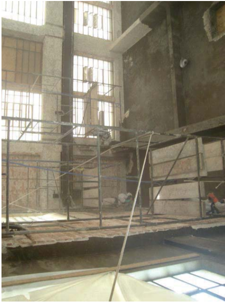
Figura 36 – Interior do edifício do incinerador, onde foi efetuada a raspagem de dioxinas e furanos
