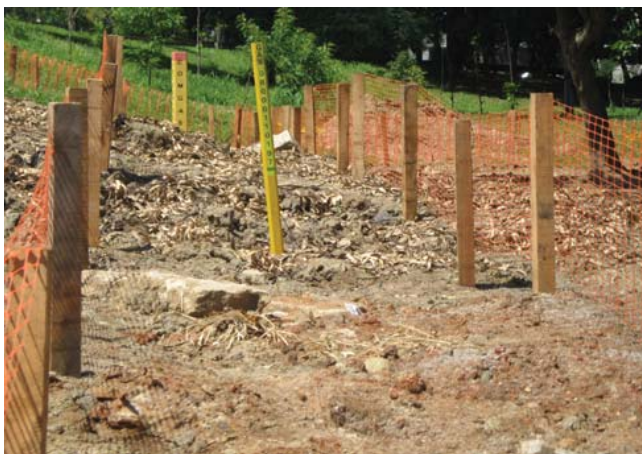
Figura 51 – Piquetes indicativos de tubulação da Comgás, na alça de acesso da Ponte do Tatuapé, vistoria realizada em 18/11/2009.
