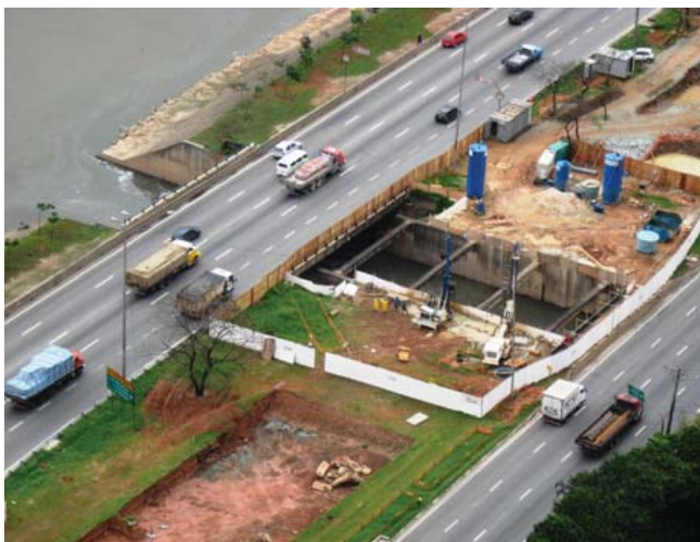
Figura 49 – Canteiro de obras para construção de Obra de Arte sobre o Córrego Mandaqui, próximo à Ponte do Limão, vistoria realizada em 24/09/2009.
