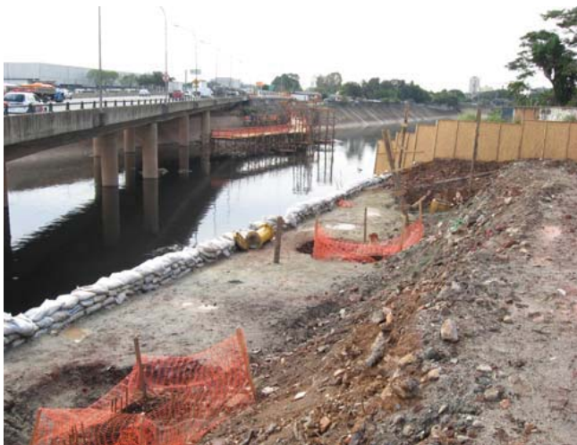
Figura 47 – Obras para construção da Ponte OAE-201, sobre o Rio Tamandateí, vistoria realizada em 19/08/2009.
