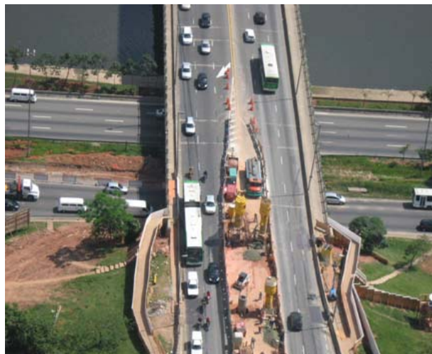
Figura 50 – Ponte Freguesia do Ó, parcialmente interditada para construção de nova obra de arte, vistoria realizada em 13/11/2009.
