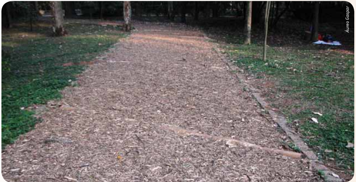
Trilha com triturado e troncos para drenagem, Parque Piqueri.
