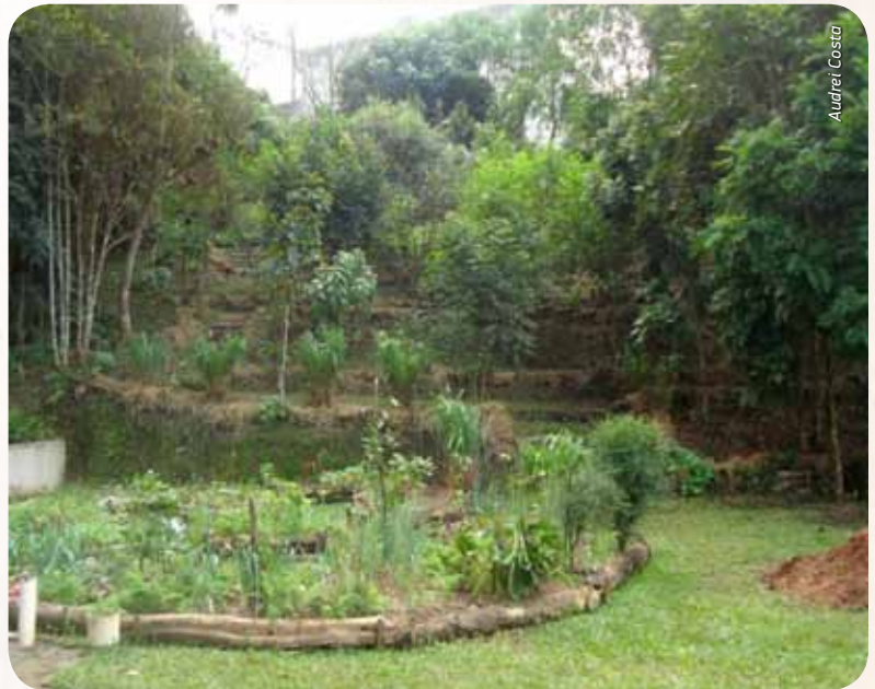
Recuperação de talude, Parque Shangrilá.
