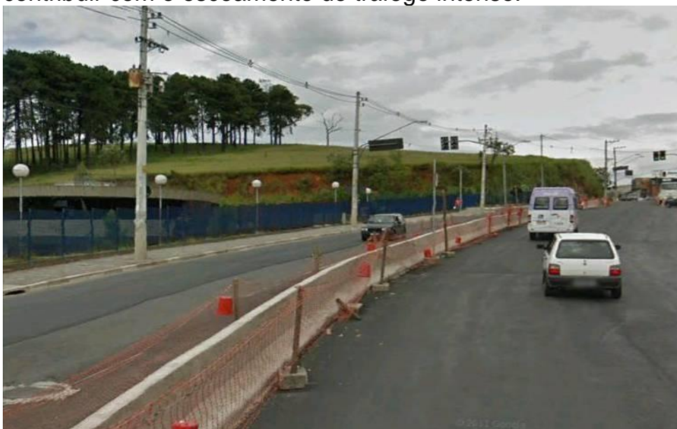
Foto 3.3.4-1 - Trecho da Estrada do M'Boi Mirim, próximo ao terminal de ônibus do Jardim Ângela. São observadas estruturas das obras de revitalização e readequação do eixo viário, parte do programa da Secretaria dos Transportes.
