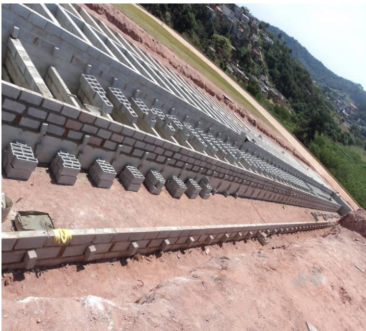
Foto 2.1.1-2 – Vista panorâmica da construção de jazigos
