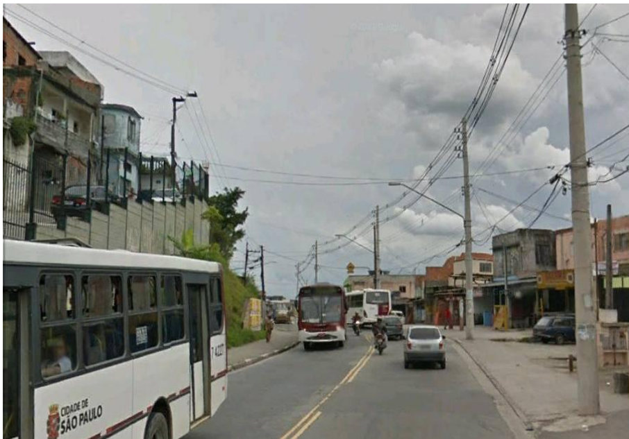
Foto 3.3.2.3-4: Início do trecho de pista simples na Estrada do M'Boi Mirim. Nota-se, também, o grande fluxo de ônibus na via e piora a no estado de conservação da pista.
