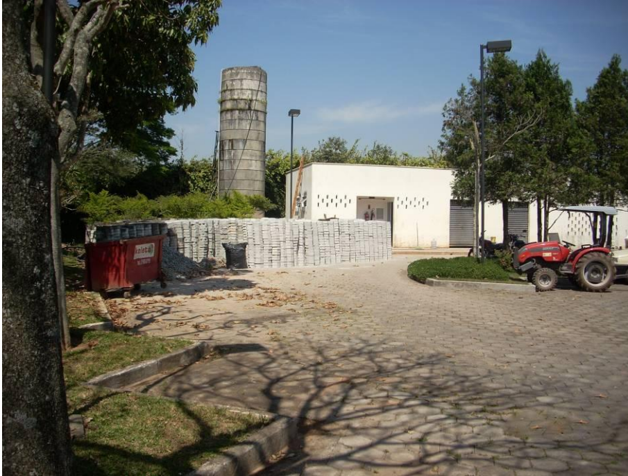
Foto 2.1.3-4 – Vista de um dos estacionamentos: Bloco de Serviços (vestiário, banheiros, fábrica de blocos, lajes, bloquetes, etc.) e a caixa d'água. À esquerda, caçamba para coleta de lixo doméstico e de varrição.
