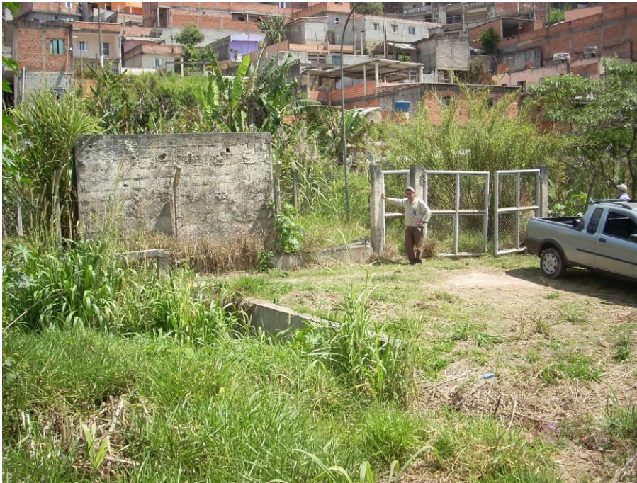
Foto 3.3.4-2 – Portão de entrada da Estação Elevatória de Esgoto da SABESP, cuja manutenção é de responsabilidade da mesma.
