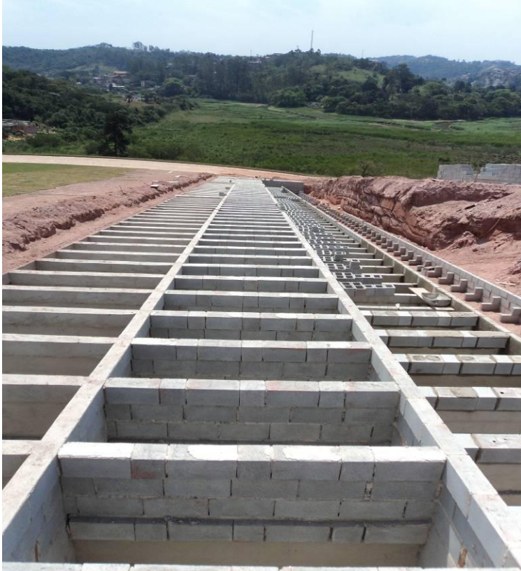
Foto 2.1.1-1 – Construção de jazigos
