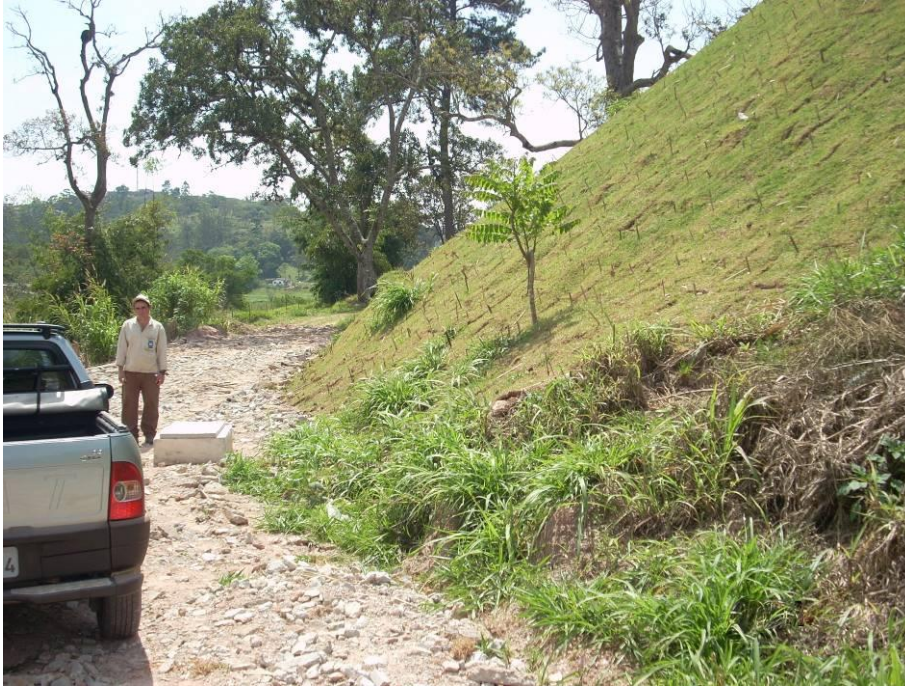
Foto 2.1.3-8 – Talude de aterro da Quadra 10, totalmente vegetado.
