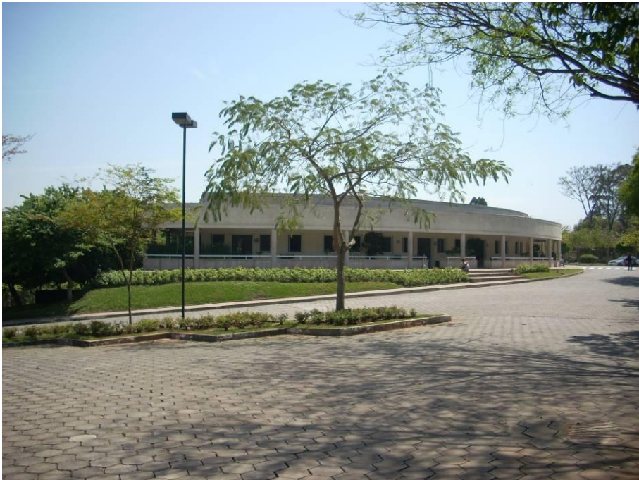
Foto 2.1.3-3 – Bloco Principal, visto a partir do Bloco de Serviços. Em primeiro plano detalhe de um dos estacionamentos.
