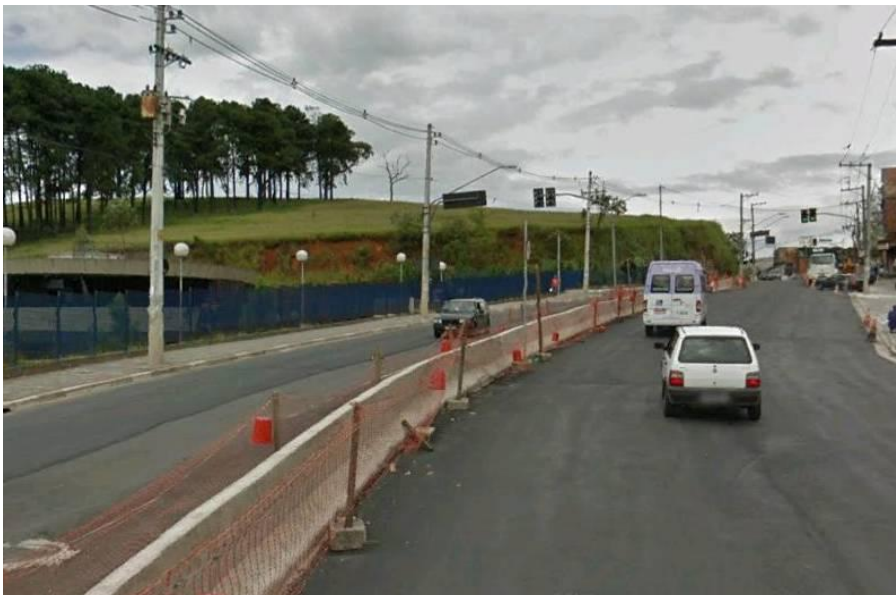
Foto 3.3.2.3-2: Estrada M'Boi Mirim, nas proximidades do Terminal de Ônibus Jardim Ângela. Até este trecho as condições de pavimento apresentam melhor estado de conservação. Em alguns pontos estão sendo realizados investimentos para melhorias da infraestrutura. Mesmo assim, o tráfego é intenso, acontecendo congestionamentos nos horários de pico.
