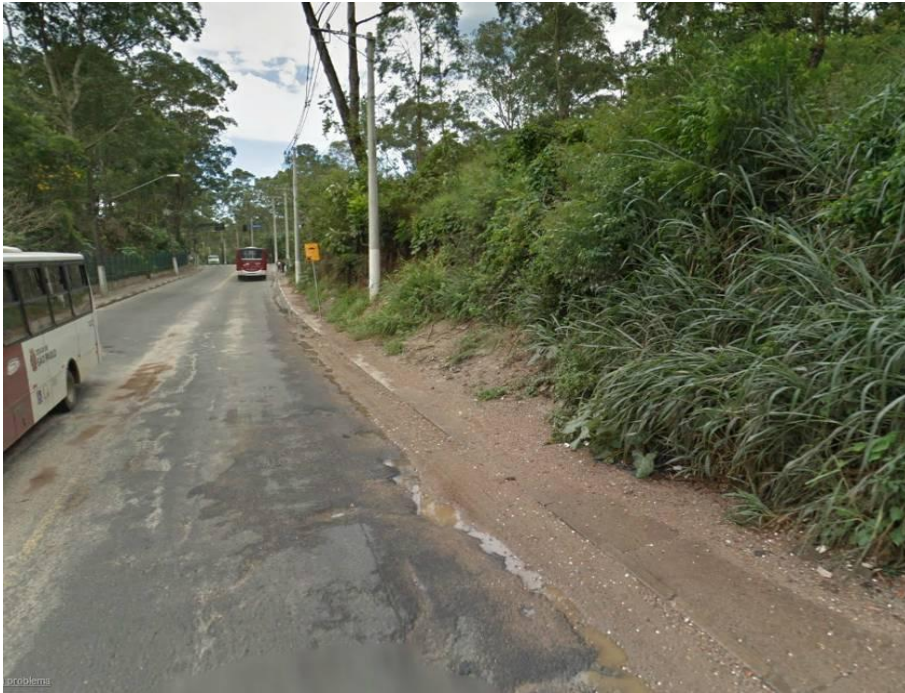
Foto 3.3.2.3-1: Detalhe das condições do eixo viário principal Estrada M'Boi Mirim, próximo ao Parque Municipal M'Boi Mirim. A via apresenta vários pontos com déficit de manutenção e em pista simples. O tráfego intenso de ônibus na via caracteriza um provável gargalo na infraestrutura de transporte.
