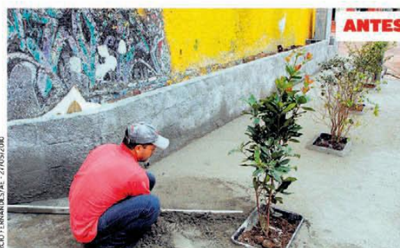
Há um ano, calçada foi reformada para tentar evitar descarte de entulho
