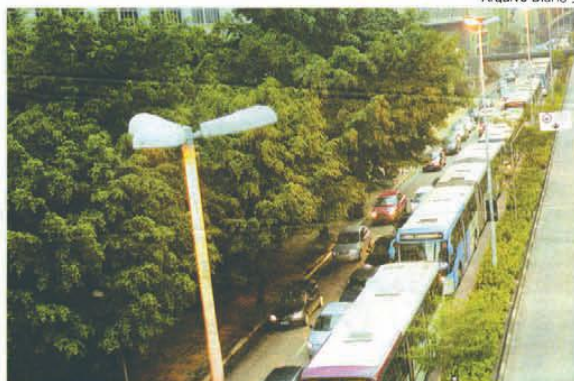
A Avenida Nove de Julho, na Zona Sul, oferece risco de morte para pedestres, motociclistas e motoristas por conta da má conservação
