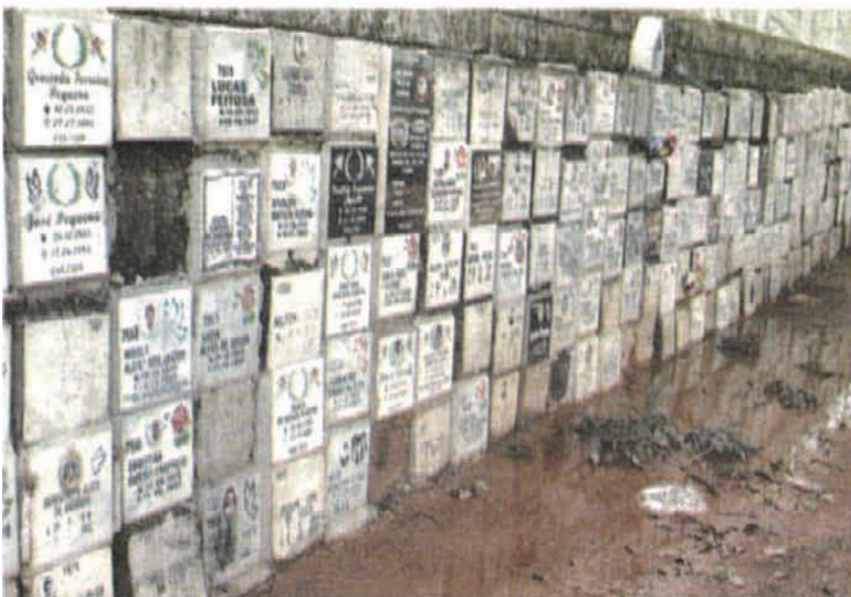
Os caminhos do cemitério estão frequentemente tomados por lama e alagamentos
