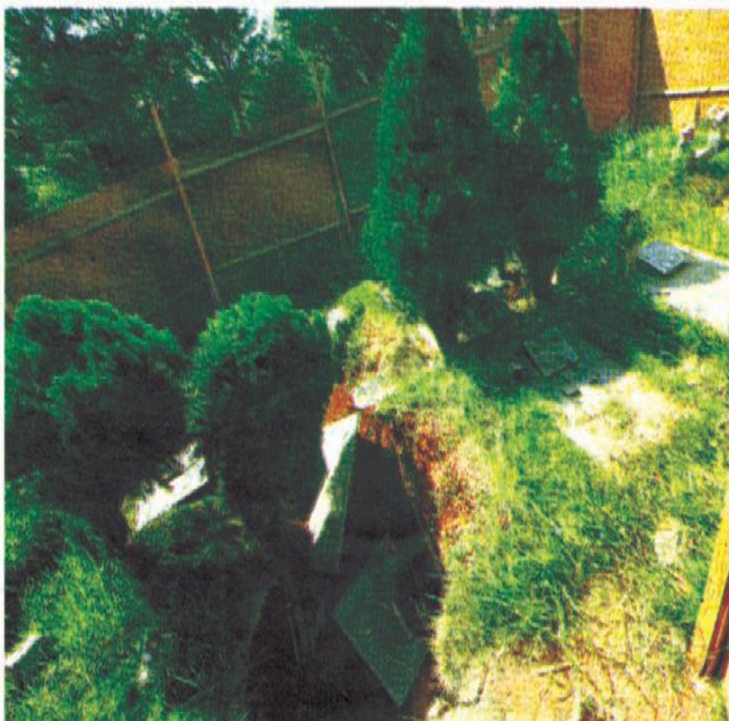
Vários buracos se formaram nos lugares dos túmulos, deixando concreto espalhado
