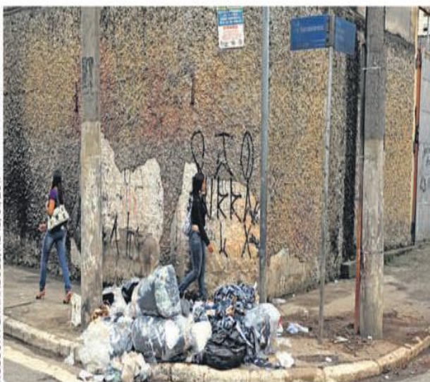
Sacos de lixo e entulho jogados em rua do Bom Retiro: risco de dengue
