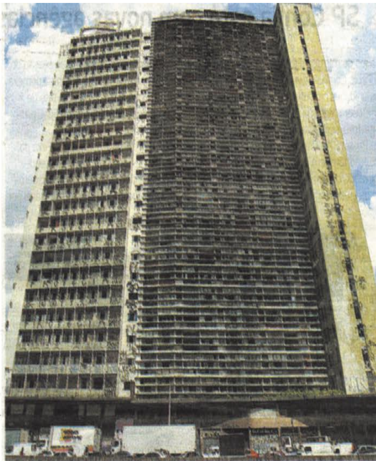
Fachada do edifício depois da sua desocupação, em 2004
