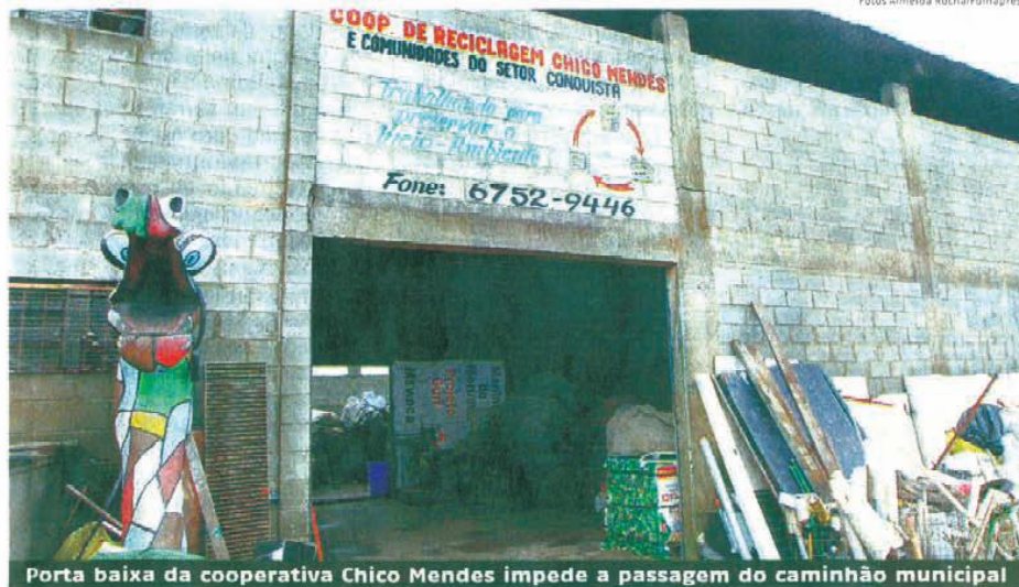
Porta baixa da cooperativa Chico Mendes impede a passagem do caminhão municipal
