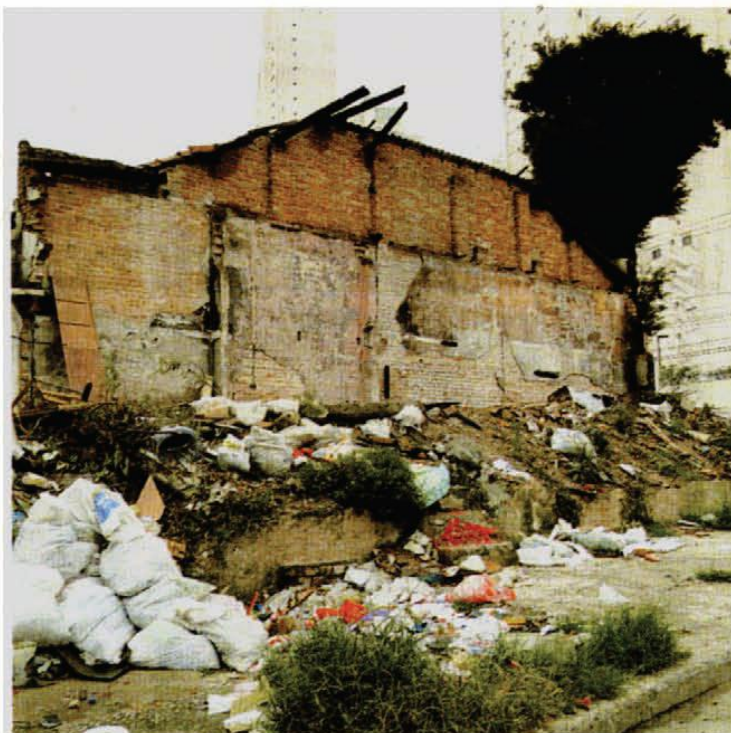
Casa demolida após incêndio virou ponto de descarte de lixo e incomoda moradores
