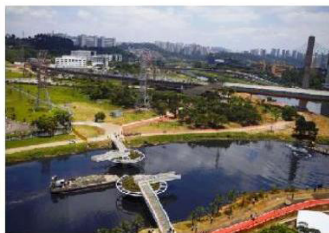
Ponte Móvel Para Ciclistas - Rio Pinheiros
