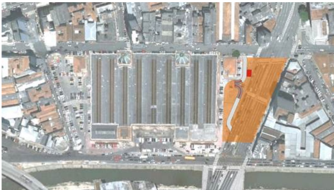
Figura 1 – Localização do estacionamento subterrâneo Mercado Municipal de São Paulo
