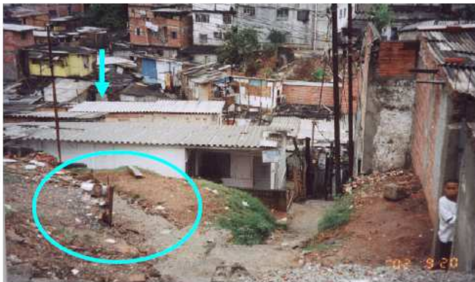
Foto 5.1.1-1: Ocupação na encosta e margem do córrego.
