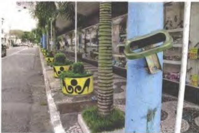
Lixeira foi arrancada na Rua Cesário Galeno, próximo à Av. Celso Garcia
