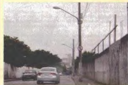
Iluminação deficiente e falta de segurança na Rua Anna Papinni Guaranha
