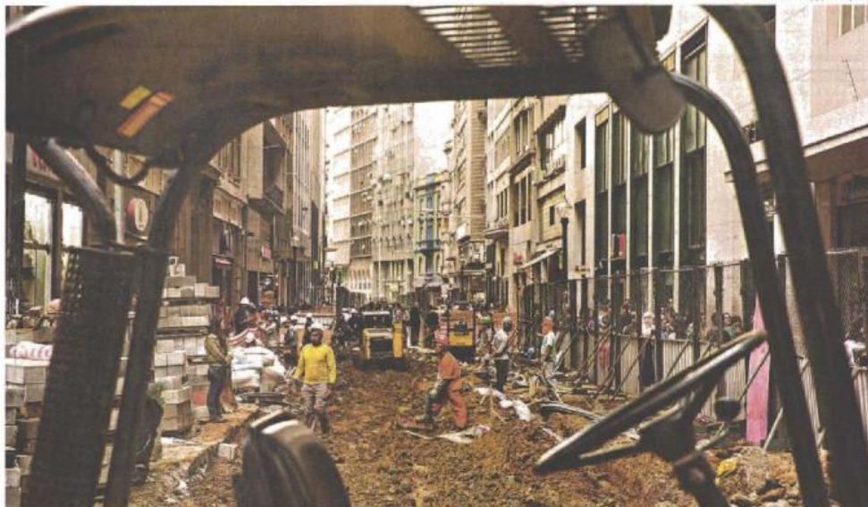
Obras do calçadão da Sete de Abril, que terá bancos e piso alinhado em blocos, que podem ser retirados sem quebrar
