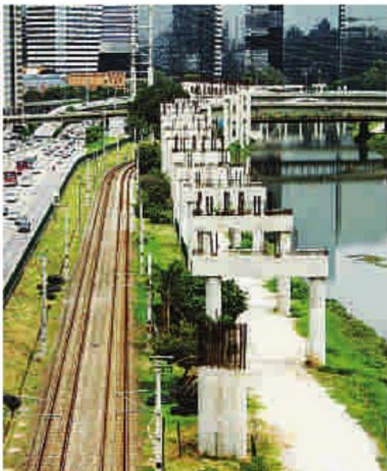
Obras do monotrilho bloqueiam trecho da Vila Olímpia à Ponte João Dias
