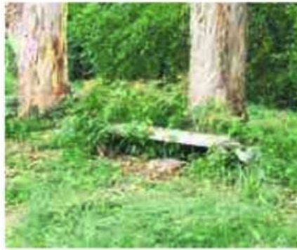
Banco da praça está quebrado e coberto por mato
