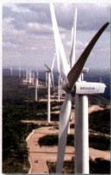
Complexo Eólico Alto Sertão I: 184 aerogeradores de 1,6 MW cada
