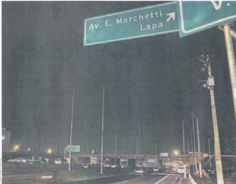
Local próximo à Ponte da Freguesia do Ó, um dos pontos que estão sem iluminação na Marginal do Tietê
