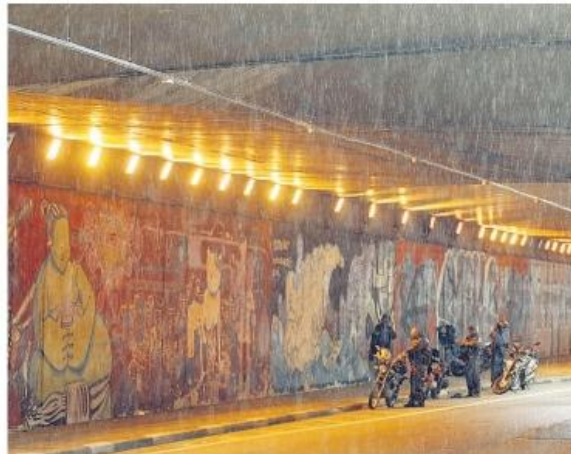
Lâmpadas estão sendo instaladas no túnel desde outubro
