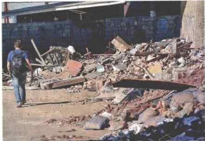
■ Ponto irregular de descarte de entulho na rua dos Patriotas, no Ipiranga (zona sul de SP); empresas ilegais transportam dois terços dos restos de obras na capital (RSP)
