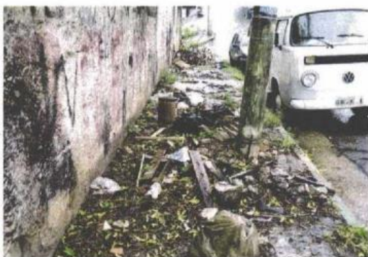
Sem manutenção, o passeio foi transformado em ponto viciado de lixo e entulho
