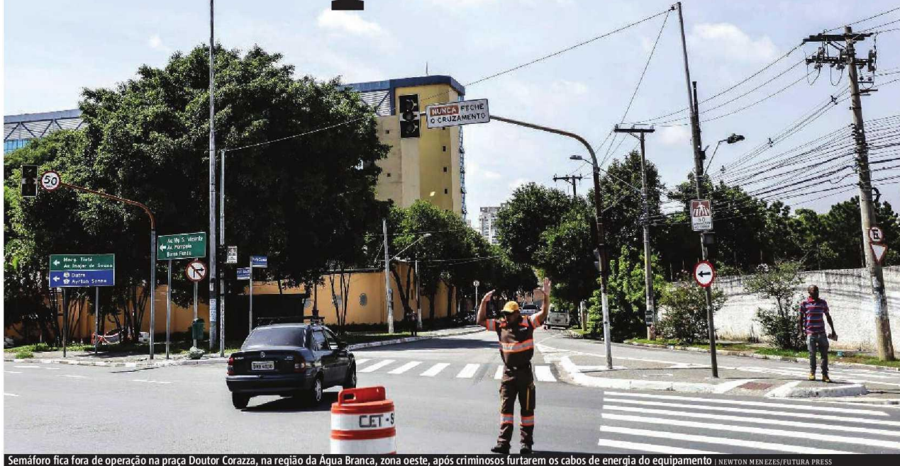
Semáforo fica fora de operação na praça Doutor Corazza, na região da Água Branca, zona oeste, após criminosos furtarem os cabos de energia do equipamento | NEWTON MENEZES/FUTURA PRESS
