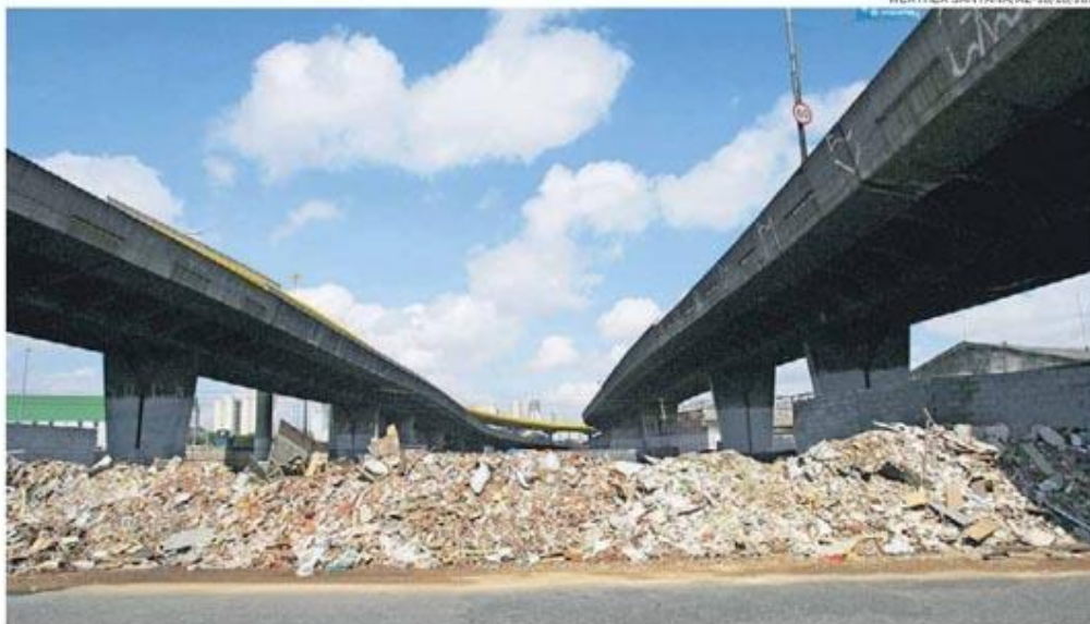
Vila Prudente. Entulho ocupa área na Av. Francisco Mesquita, sob o Viaduto Grande São Paulo
