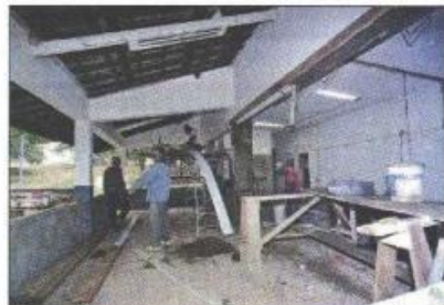
Obra sendo realizada na Quadra de Bocha reservada aos idosos
