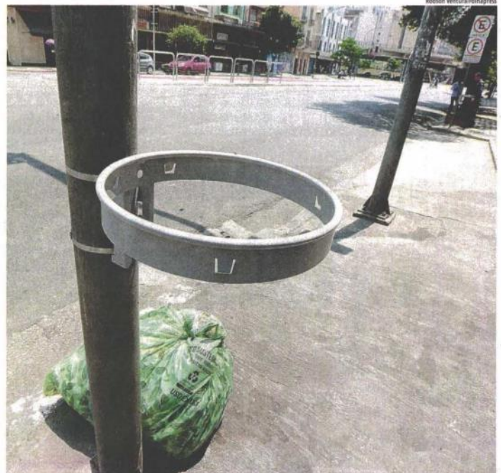
■ Aro de metal instalado na esquina da avenida São João com a rua Ana Cintra está sem saco de lixo; apenas 15 equipamentos estavam em condições de uso
